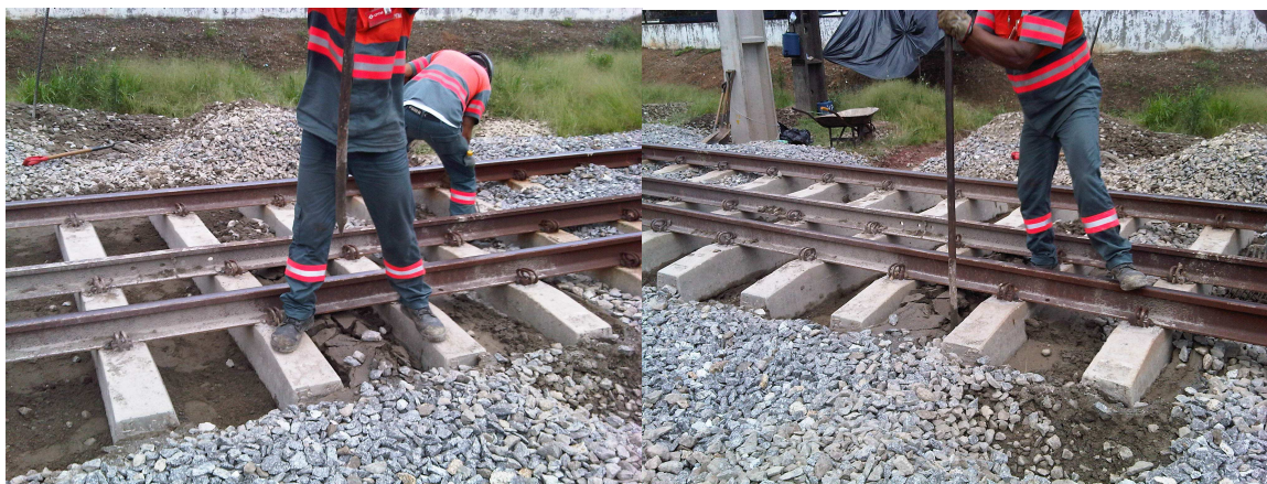
Figura 9. Manutenção/limpeza manual do Lastro
