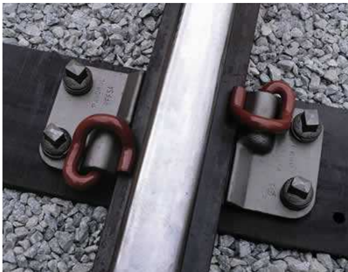
Figura 6. Foto da fixação elástica tipo pandrol (Fonte: Acervo pessoal, 2014)
