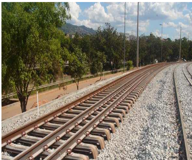
Figura 3. Dormentes produzidos em metal e a via construída com esse material (Fonte: Acervo pessoal, 2014).
