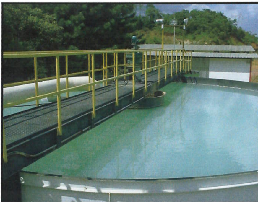
FIGURA 3.6.3. – Vista superior do clarificador. Nota-se a água clarificada e tratada, que é destinada para a lagoa de reuso.
