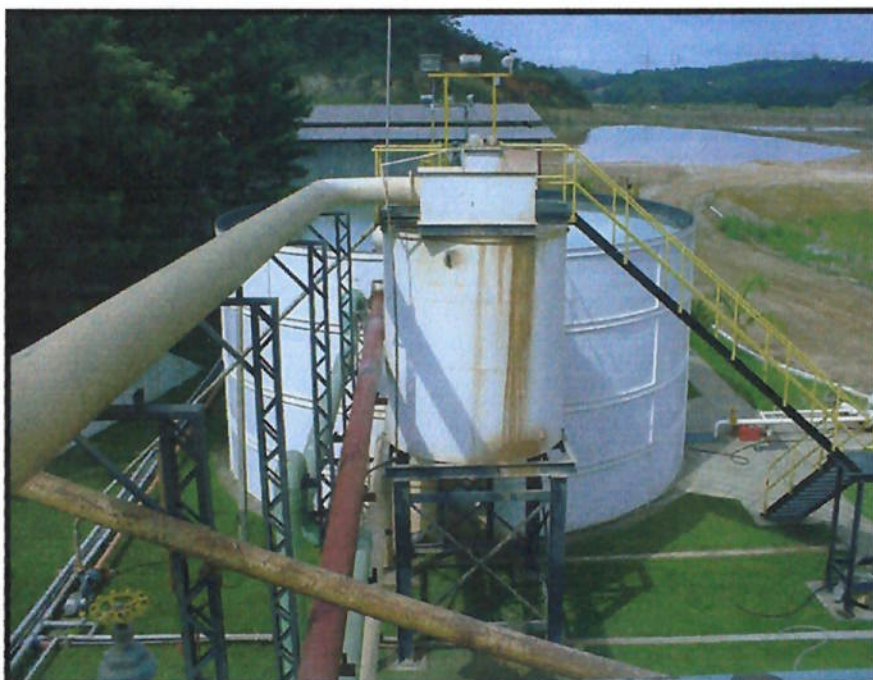
FIGURA 3.6.4. – Em primeiro plano, o tanque de reação dos produtos químicos utilizados nos processos de coagulação e floculação.
