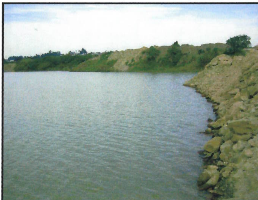
FIGURA 2.1.3.4. - Lagoa que recebe água tratada no processo e fornece água limpa para os trabalhos de mineração realizados no empreendimento.
