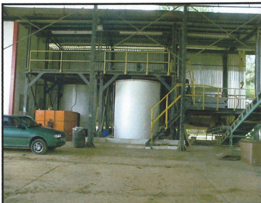
FIGURA 3.6.5. – Tanques de preparação dos produtos químicos (cloreto de cálcio e polieletrólito) que são lançados no tanque de reação.
