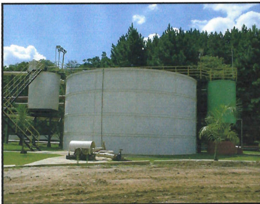
FIGURA 3.6.2. – Clarificador onde ocorre o processo de clarificação e tratamento da água servida. Ao lado, observa-se o tanque menor de reação química.
