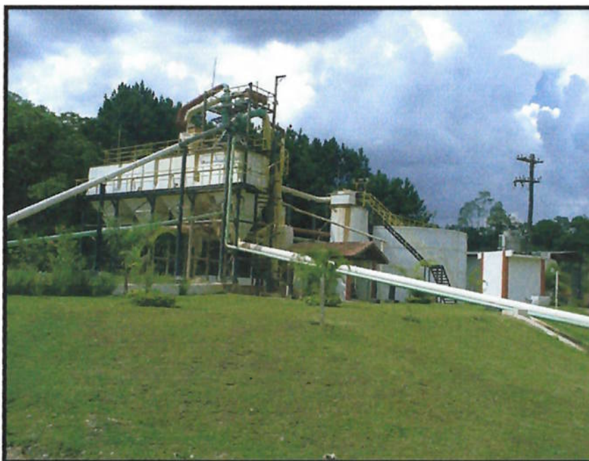
FIGURA 2.2.3.4. – Vista dos silos de armazenamento e estocagem de produtos e, ao fundo, o clarificador utilizado na etapa seguinte de tratamento de efluentes.
