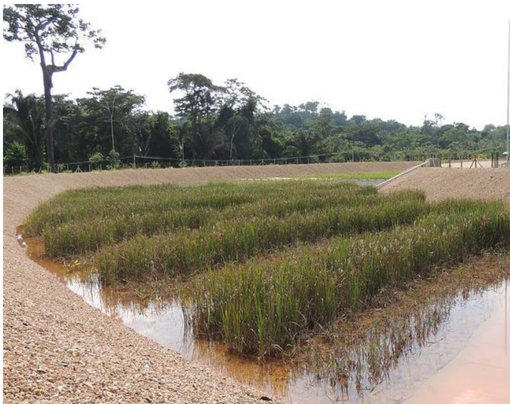
Figura 7 – Wetland construído
