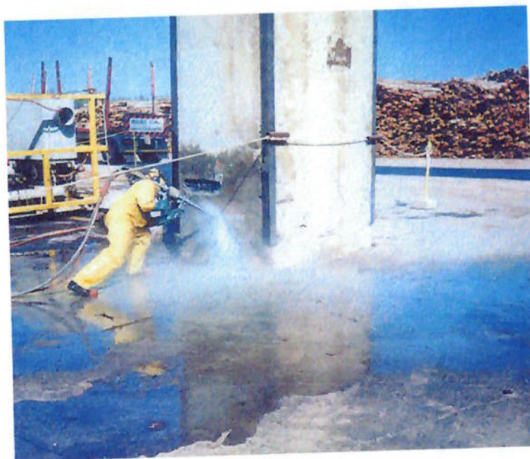
Figura 5. Demolição de concreto e decapagem da armação metálica. Fonte: RODRIGUES, 2002.
