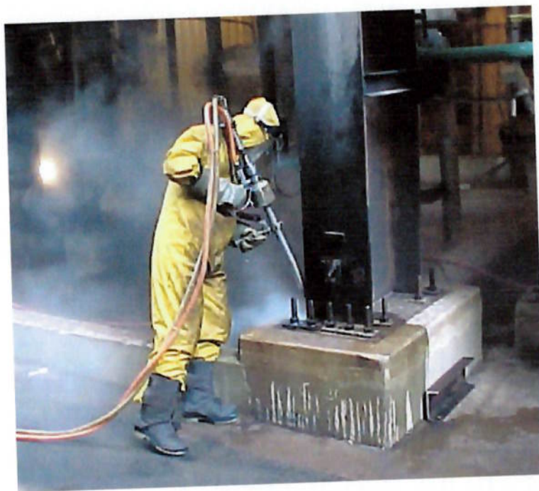
Figura 13. Utilização de EPI para a decapagem de estrutura metálica para recuperação de pintura. Fonte: RODRIGUES, 2002.
