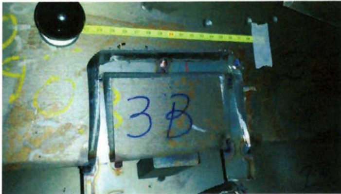
Figura 4.8 – Montagem típica para reparos próximos ao cubo do rotor (Identificação B)
