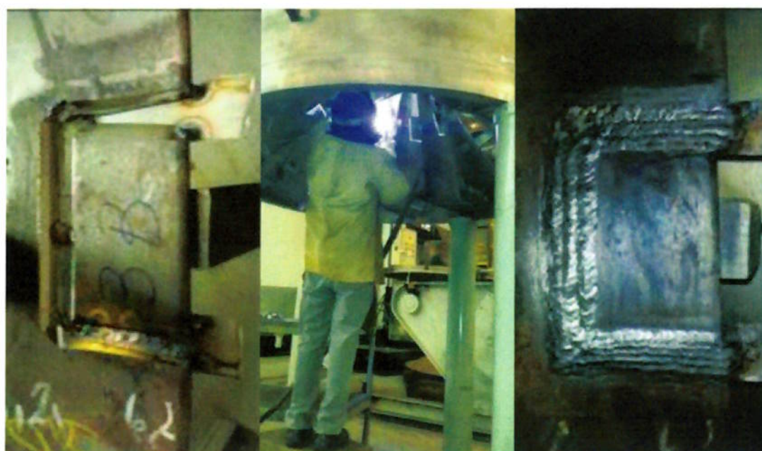
Figura 4.11 – Soldagem por processo GTAW
