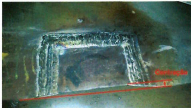
Figura 5.18 – Contração típica observada nos reparos por processo GTAW, vista frontal
