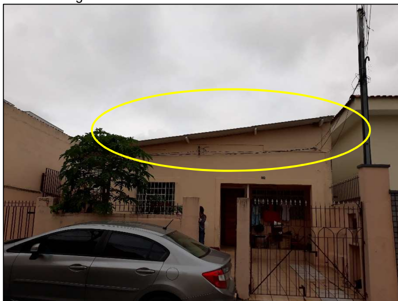
Figura 11 – Fachada – telhado de fibrocimento
