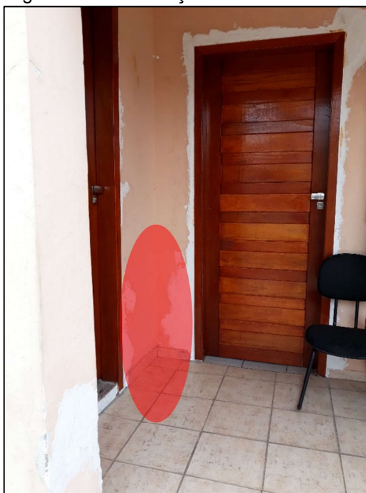
Figura 22 – Localização extintor 3 - entrada
