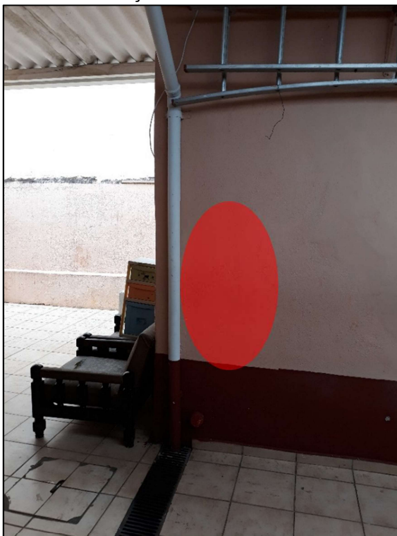
Figura 21 – Localização extintor 2 - início corredor interno
