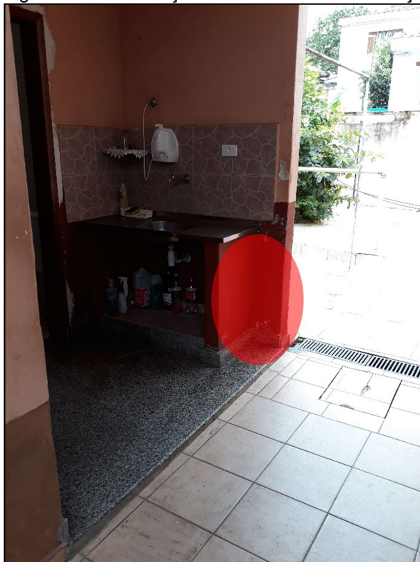
Figura 20 – Localização extintor 1 - área de serviço
