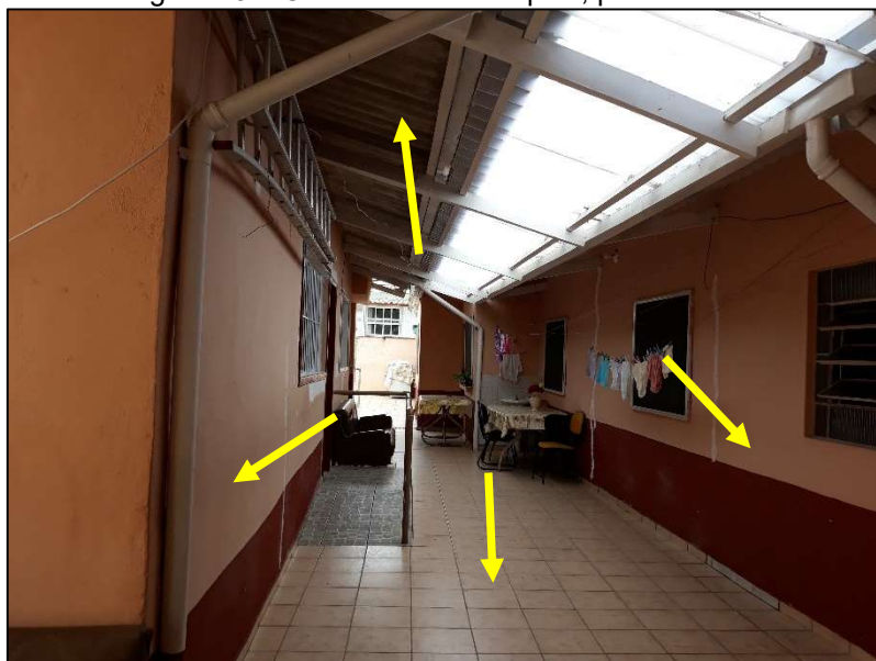
Figura 13 – Corredor interno – piso, parede e teto
