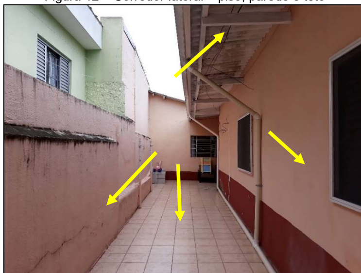
Figura 12 – Corredor lateral – piso, parede e teto
