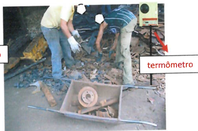
Figura 13: Local de medição da situação 2.
