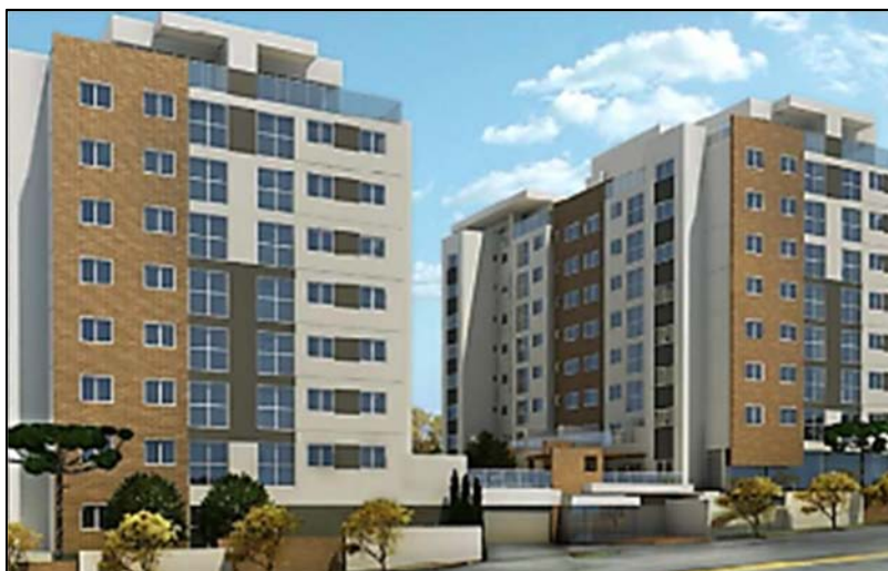
Figura 26 - empreendimento com duas torres e 7 pavimentos.
