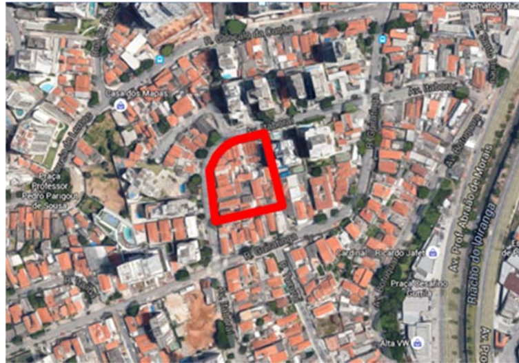
Figura 21 - Terreno escolhido para a implantação do empreendimento protótipo Chácara Inglesa. (Fonte: Google Maps).
