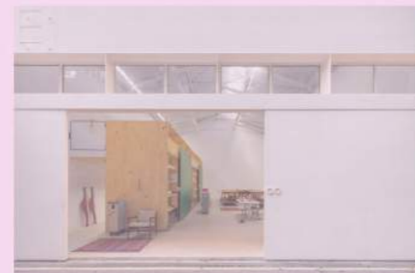
OFICINA EM PERDIZES | MMBB ARQUITETOS | SÃO PAULO | 2020
