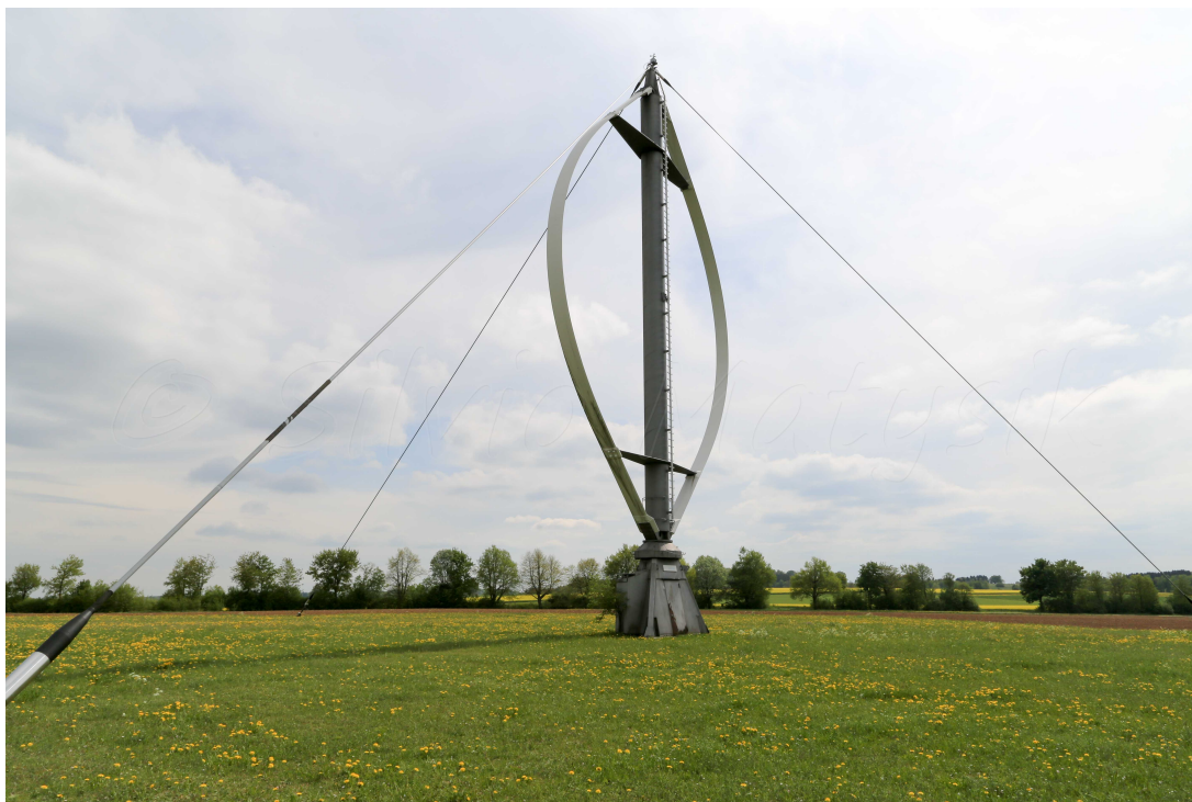
Figura 28 – Dornier Darrieus, 55 kW, 25 m de altura, com cabos de apoio claramente visíveis.
