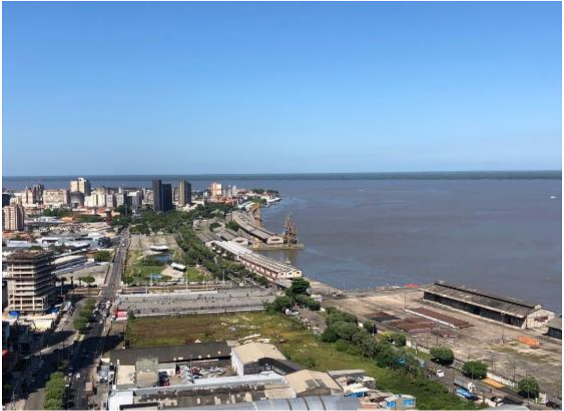
Imagem 6 – Vista diurna dos galpões do Porto de Belém
