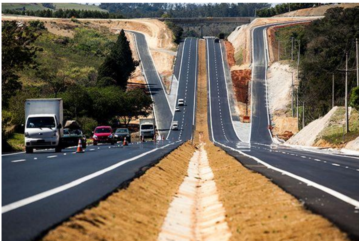
Figura 14 - Modernização da Rodovia Raposo Tavares (km 295)
