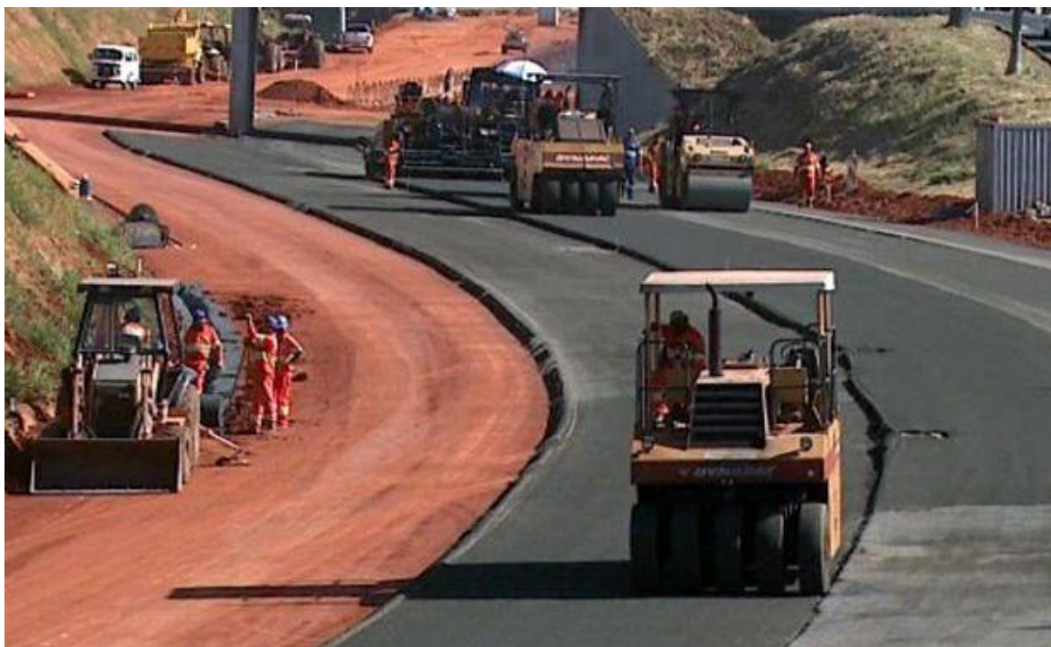
Figura 13 - Obra da nova pista sentido Sul da Rodovia João Mellão em maio de 2017
