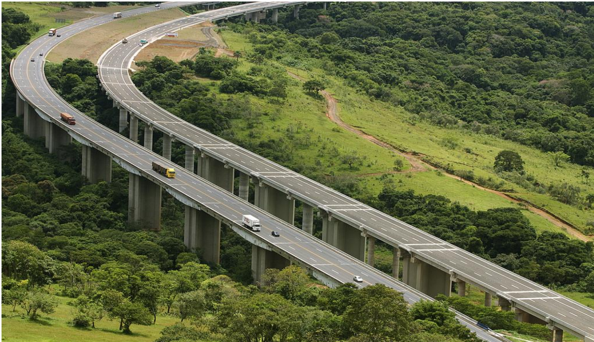
Figura 12 - Duplicação do Viaduto da Castelo Branco
