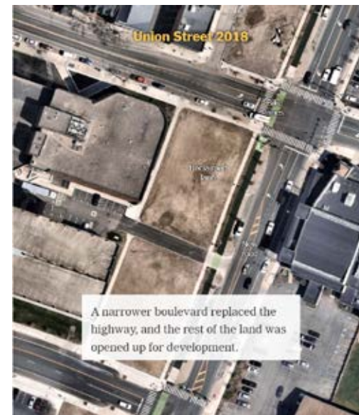
IMAGEM 61 - A avenida após conclusão das obras
