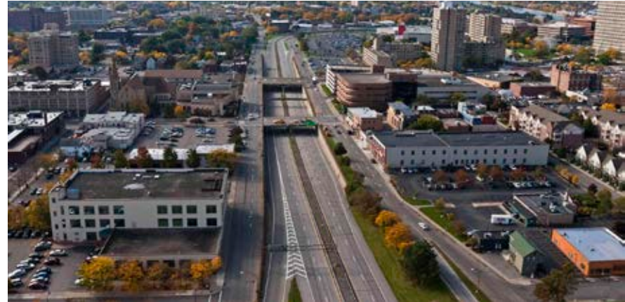
IMAGEM 66 - Vista aérea da via expressa antes da intervenção
