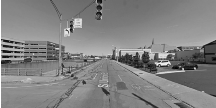
IMAGEM 64 - Street View da via expressa antes da intervenção
