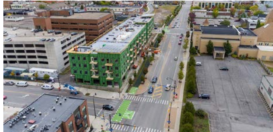
IMAGEM 67 - Vista aérea da avenida após a intervenção
