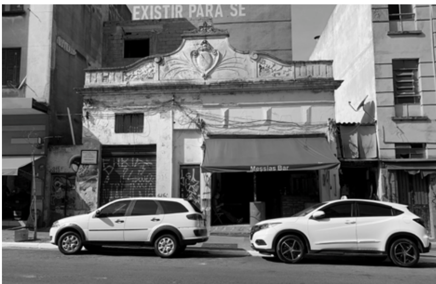
IMAGEM 47 - Edifício tombado na região da Ligação
