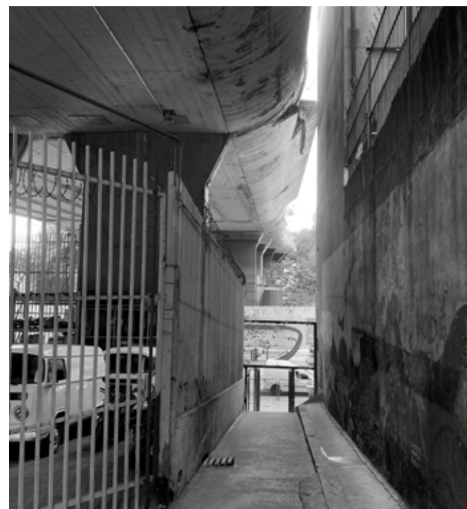
IMAGEM 04 - Passagem sob a via na região da Av. 9 de Julho
