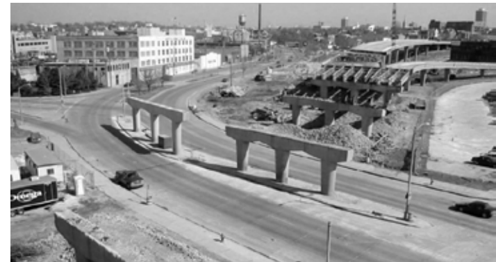
IMAGEM 50 - Demolição do Park East Freeway em Milwaukee
