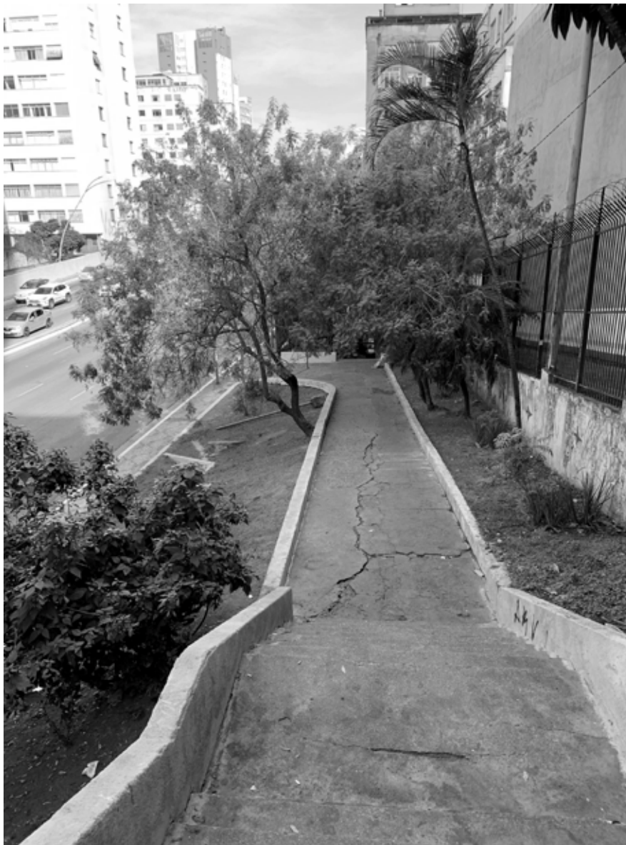
IMAGEM 37 - Escada que dá acesso a Ligação na R. Augusta, realizando a transposição até a Av. 9 de Julho
