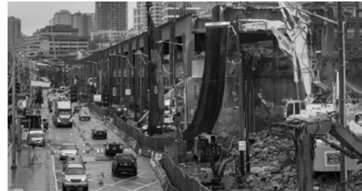
IMAGEM 49 - Demolição do Alaskan Way Viaduct em Seattle
