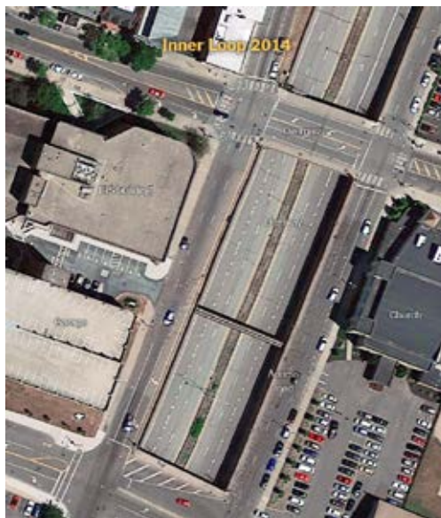
IMAGEM 60 - Antes da obra de readequação da via
