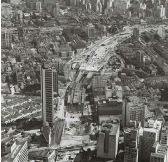
IMAGEM 29 - Construção de viaduto no Bixiga
