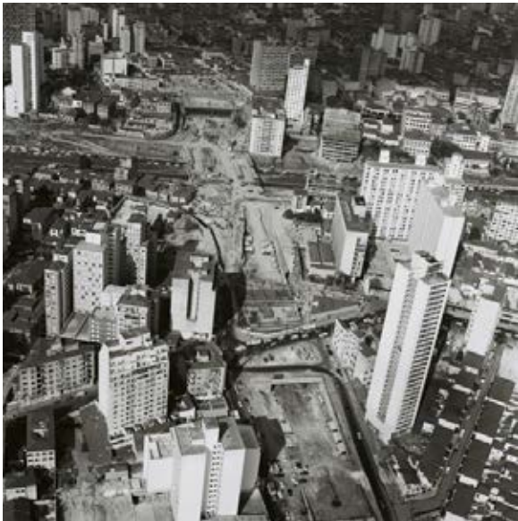
IMAGEM 30 - Construção do Viaduto Jaceguai, sobre 23 de Maio
