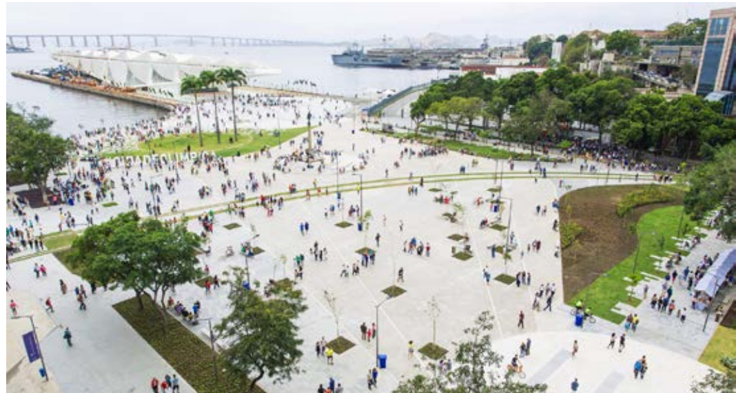
IMAGEM 57 - Praça Mauá após a demolição do viaduto
