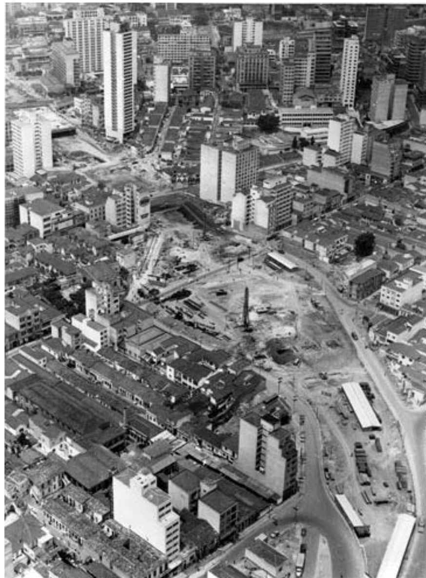
IMAGEM 28 - Construção da Ligação na região do Bixiga; área de futura alça de acesso
