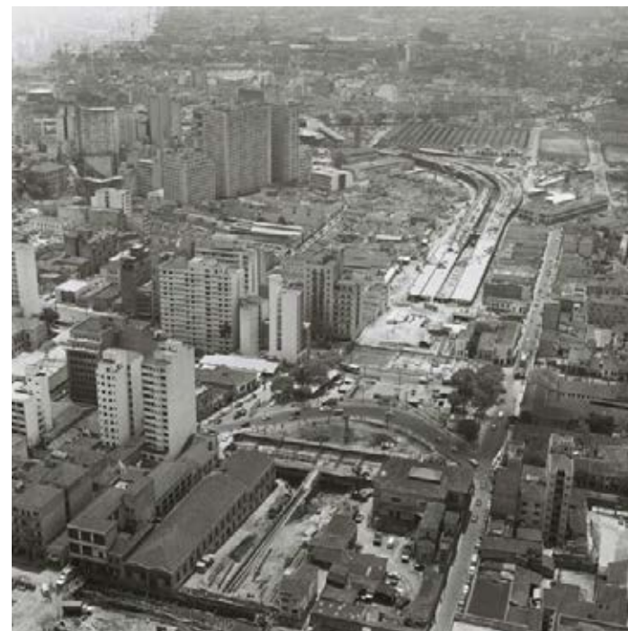
IMAGEM 31 - Construção da via na área da Praça Almeida Júnior
