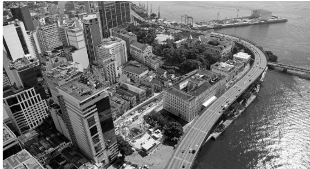
IMAGEM 56 - Av. Perimetral na orla do Centro do Rio de Janeiro, antes da intervenção
