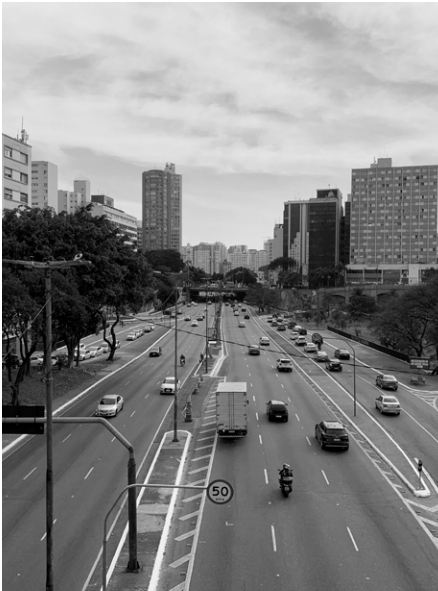
IMAGEM 05 - Trecho da Ligação-Leste Oeste que transpõe a Av. 23 de Maio
