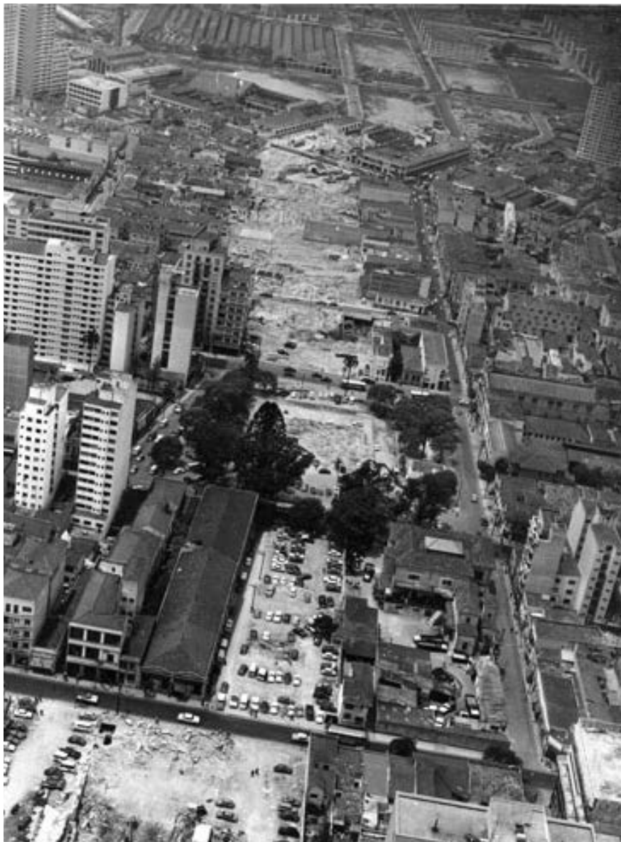
IMAGEM 27 - Construção da Ligação na região da Liberdade em direção ao Glicério
