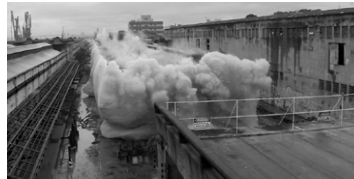
IMAGEM 51 - Demolição da Perimetral no Rio de Janeiro
