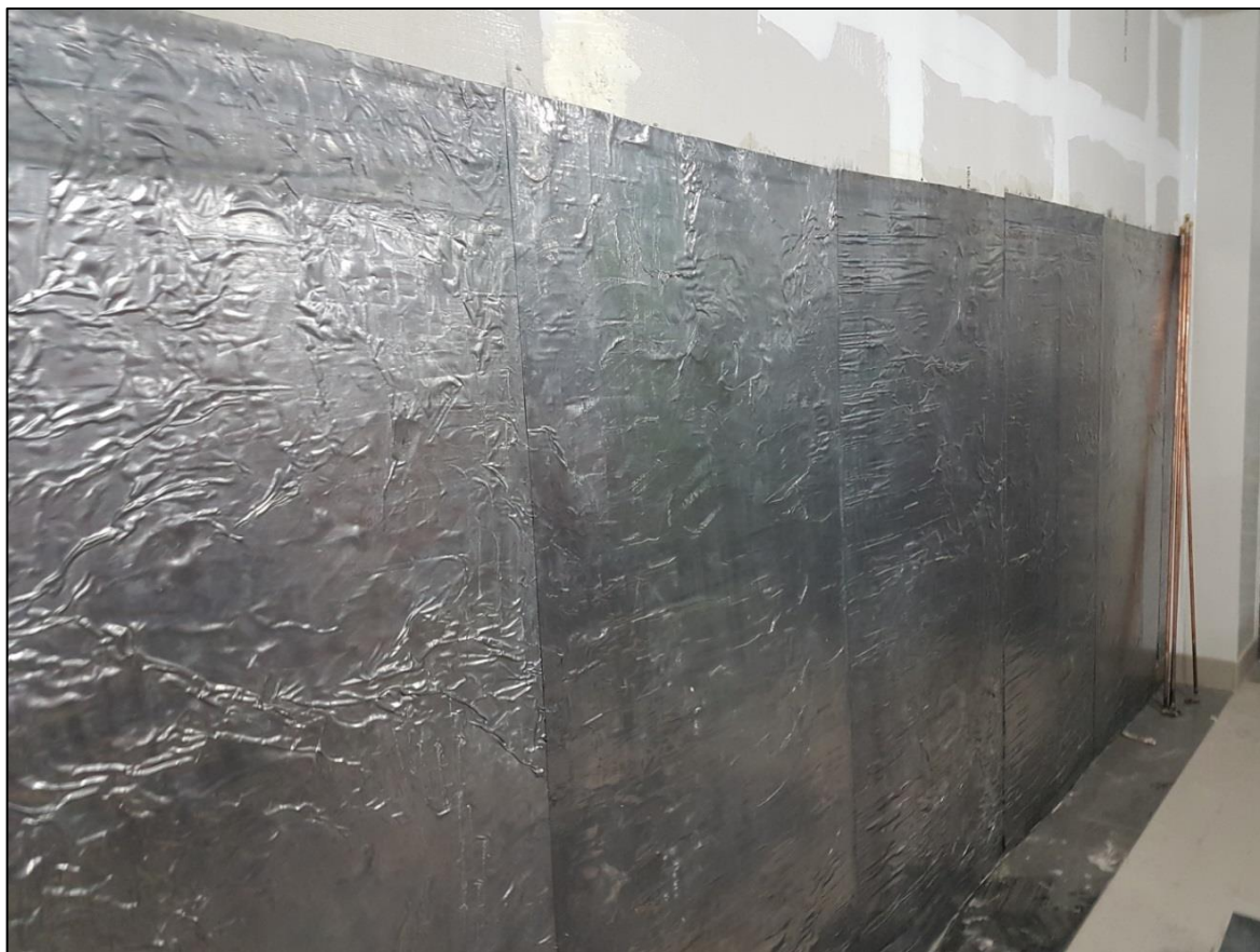
Figura 8 – Fase de obras da sala de tomografia computadorizada.
