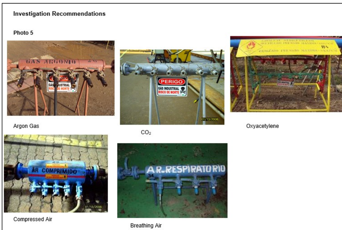
Figura 8 - Tipos de Manifolds do Estaleiro XPTO – Fonte: o Estaleiro XPTO
