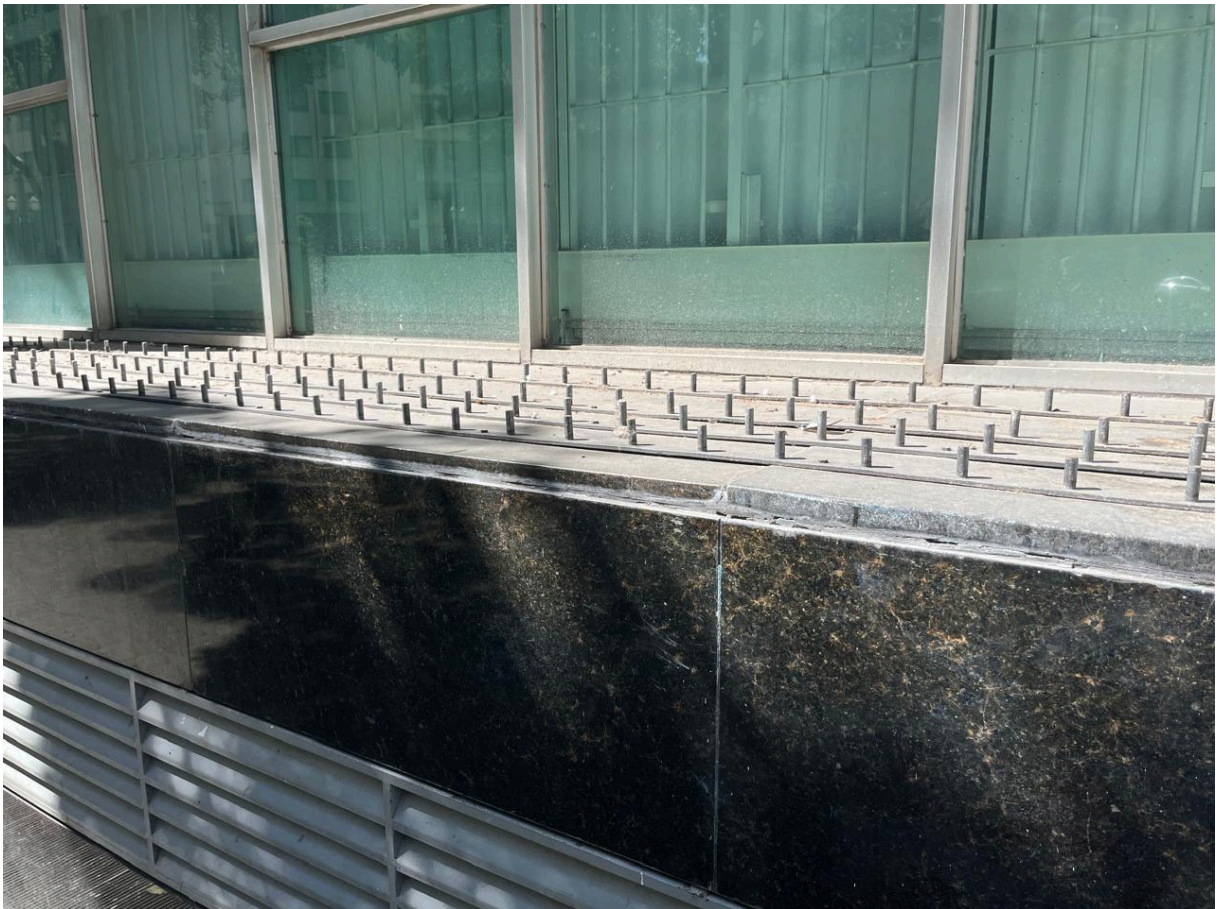
Figura 4 – Estacas metálicas dispostas sobre fachada de prédio na República
