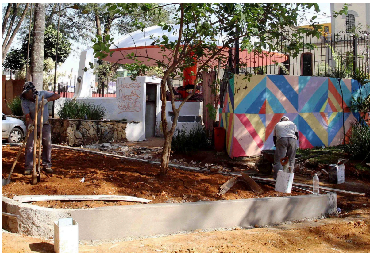
Figura 7 – Obra da Praça Padre João Álvares
