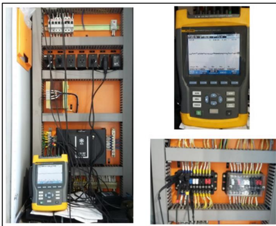
Figura 19. Instalação do Analisador de QEE
