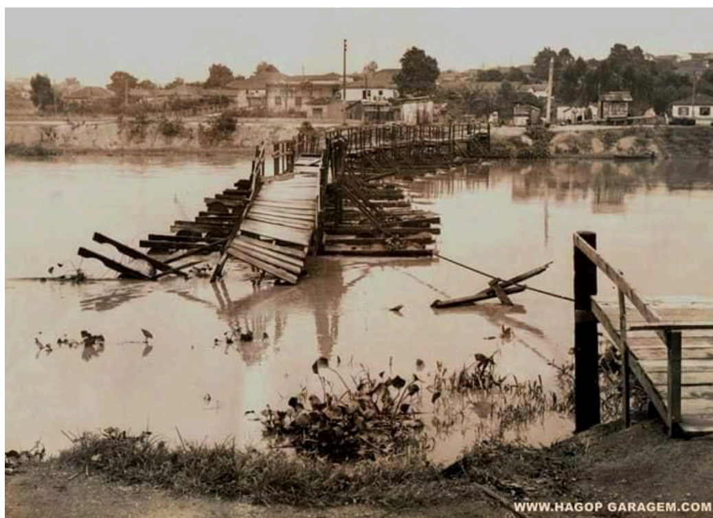
Figura 17: Ponte de tambor destruída pela força das águas. 10/01/1963.
