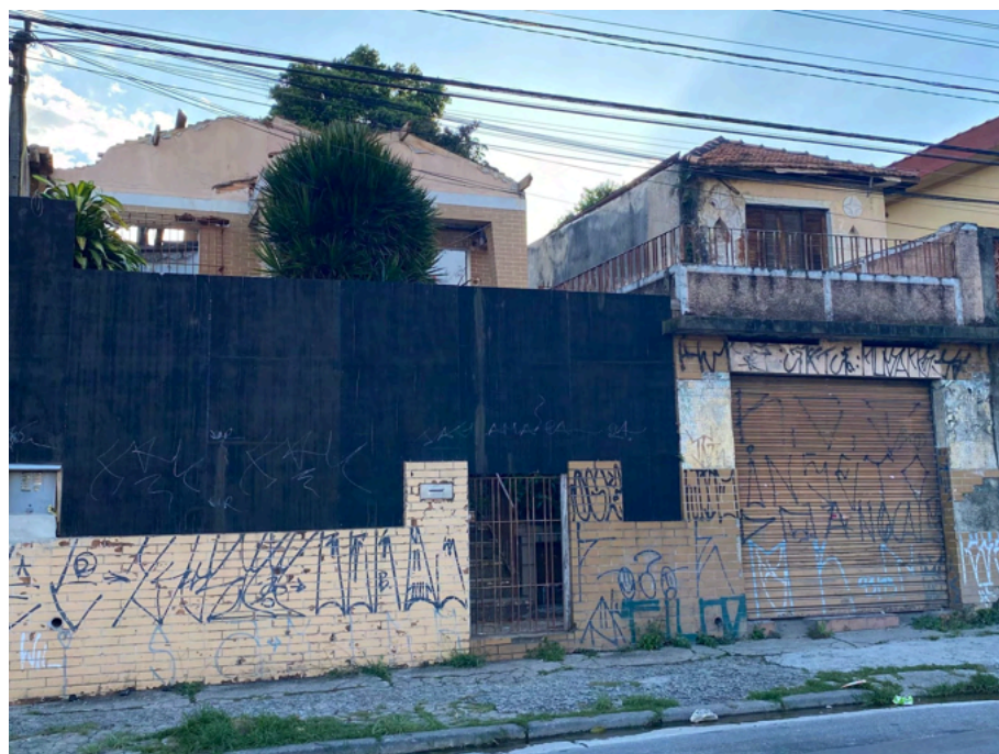
Foto 7: Residência sendo demolida na Rua Antônio Ayrosa.
