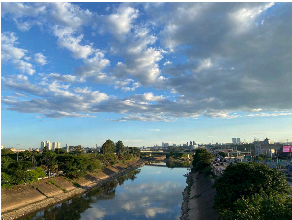
Foto 14: Rio Tietê visto em fotografia tirada sobre a Ponte dos Remédios.
