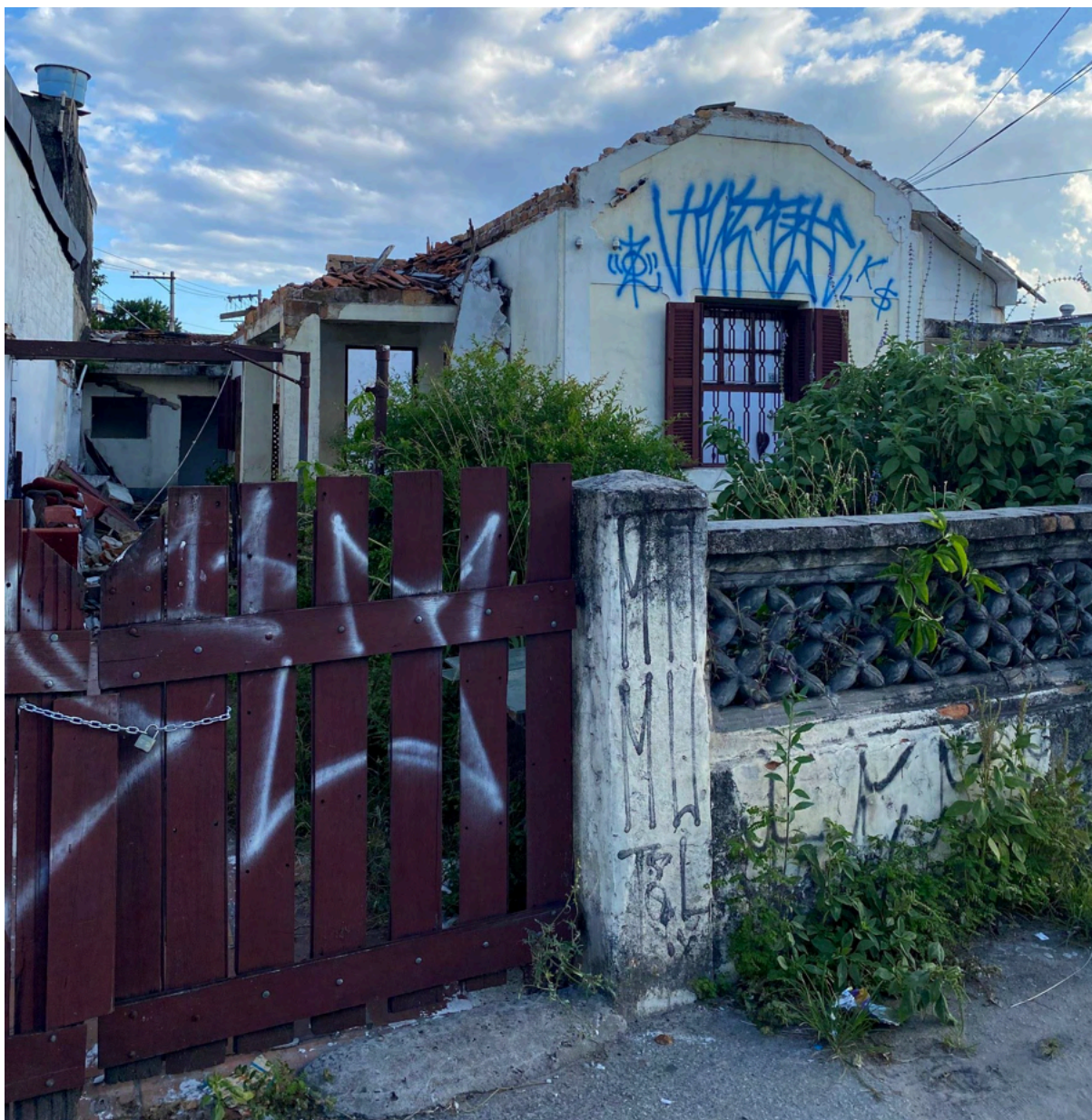
Foto 3: Residência na Avenida dos Remédios em fase de demolição.
