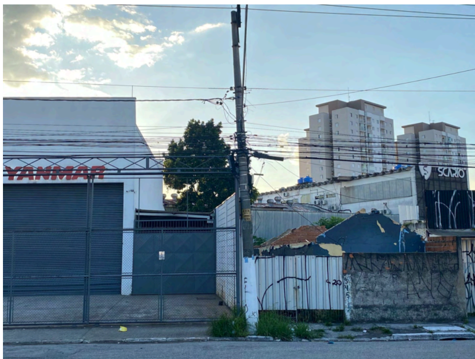
Foto 6: Galpão de máquinas agrícolas ao lado de casa em fase de demolição próximo à Ponte dos Remédios. Ao fundo, prédio residencial recém inaugurado.
