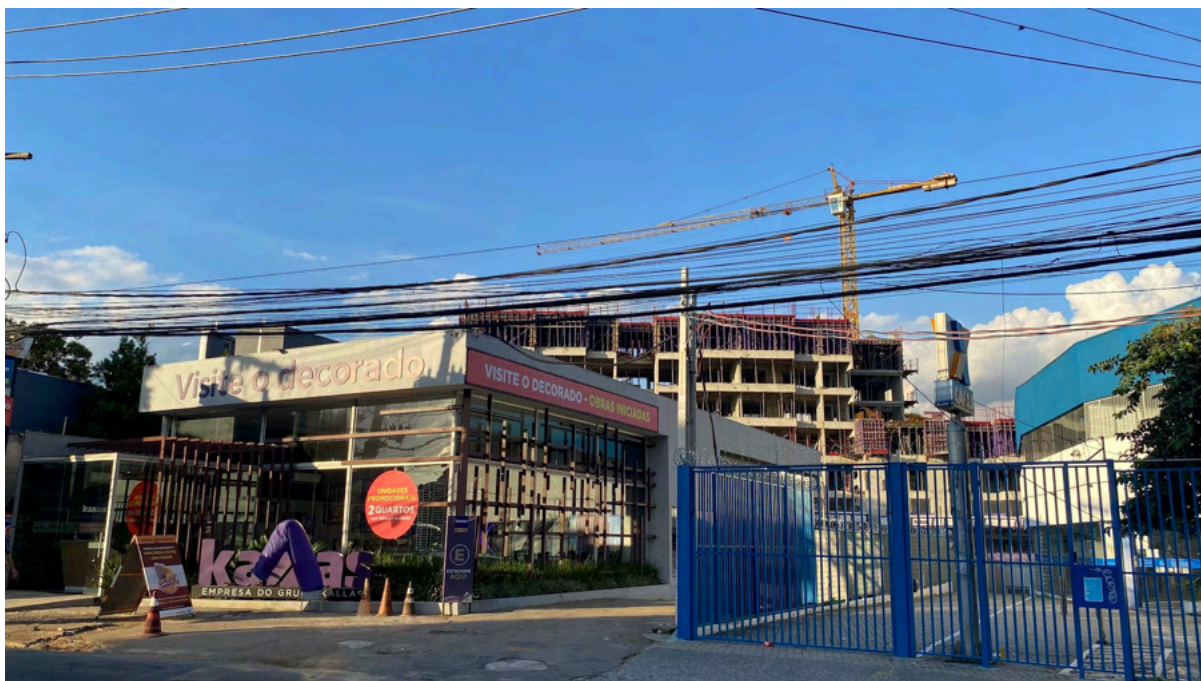
Foto 8: Empreendimento imobiliário em construção na Avenida dos Remédios.
