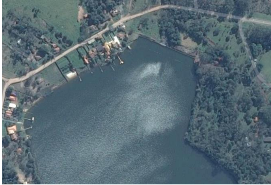
Figura 7: Imagem aérea da Zona de Barragem do reservatório, local onde se localizado o ponto 1 (P1).
