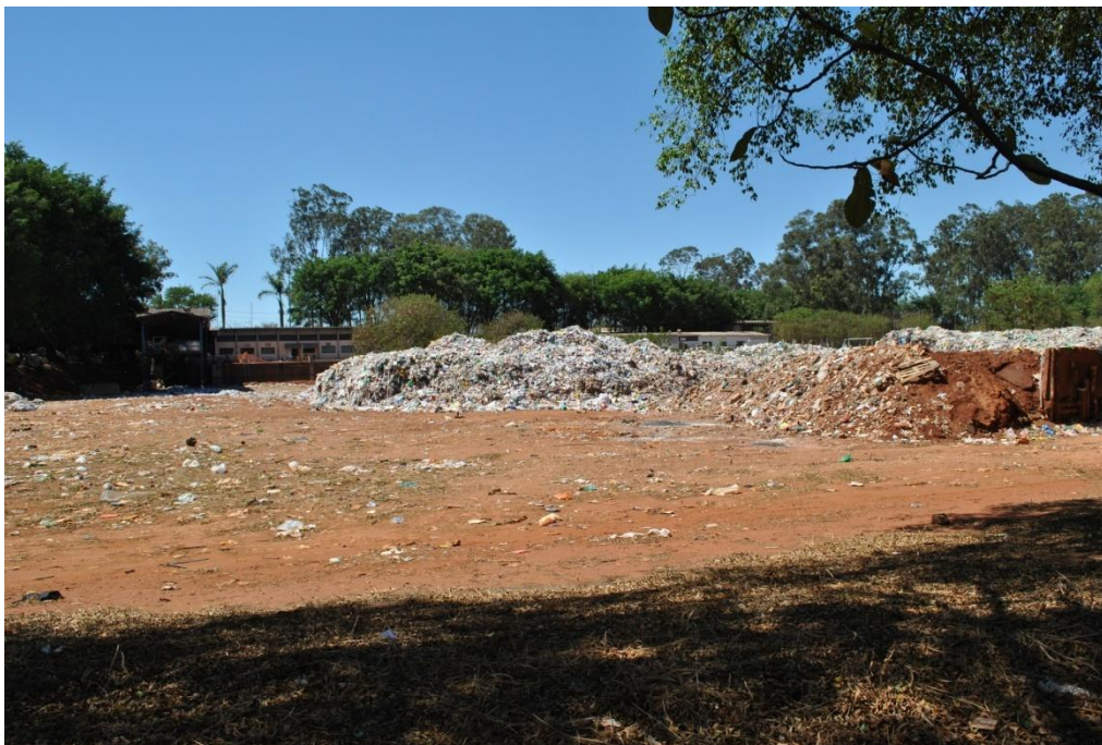
Figura 20 - Monte do Rejeito (materiais no reaproveitveis)
