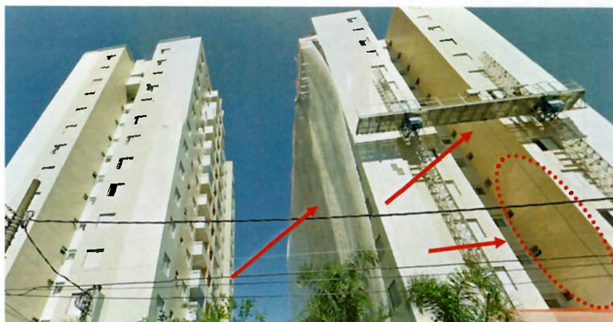
Foto 21: Vista da recuperação do revestimento da fachada
