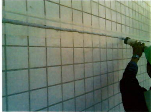
Foto 18: Preenchimento completo dos vãos - acabamento com espátula
