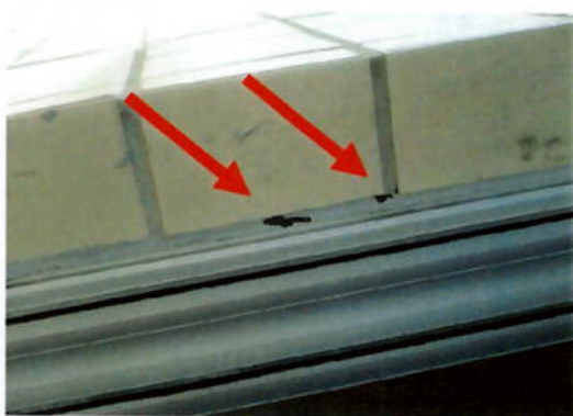
Foto 15: Falha de vedação
