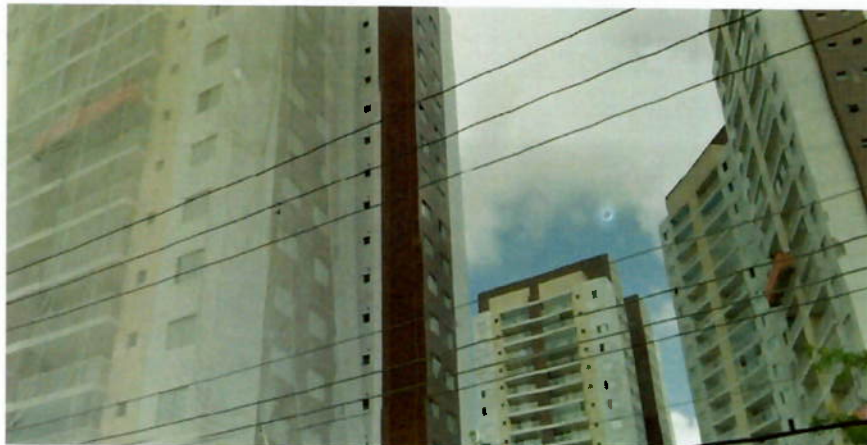
Foto 12: Vista da recuperação do revestimento da fachada
