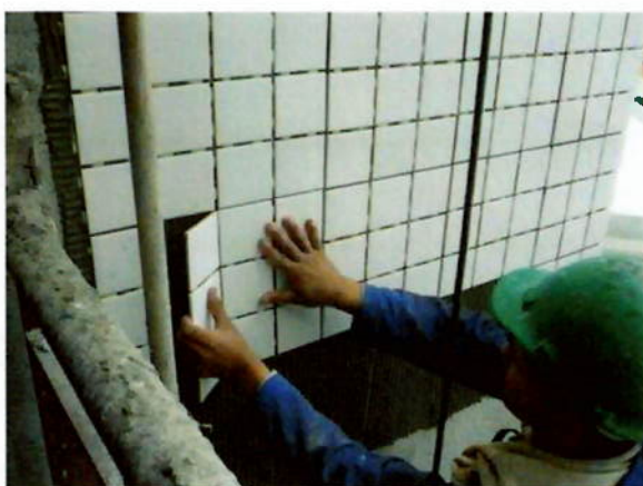
Foto 6: Atenção com as viradas para garantir alinhamento horizontal
