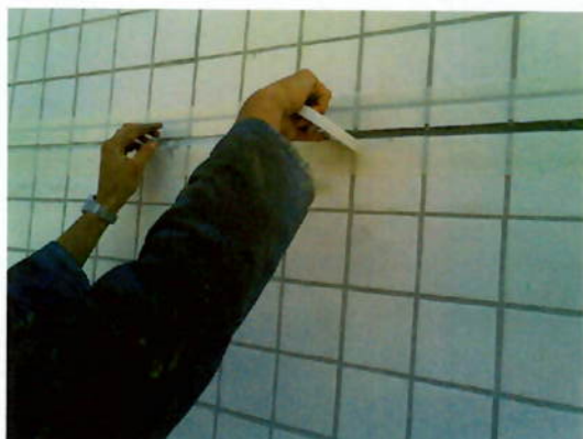
Foto 16: Fita de fundo de borda (retirar excesso de sujeira dos vãos)
