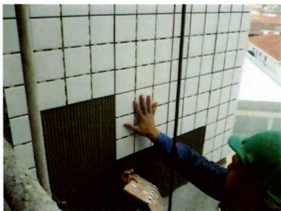
Foto 6: Atenção com as viradas para garantir alinhamento horizontal
