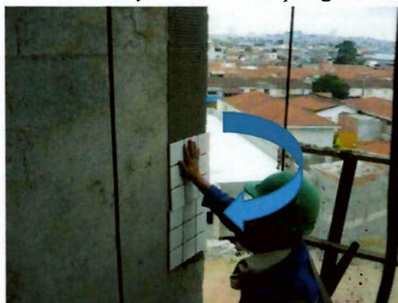
Foto 4: Atenção com as viradas para garantir alinhamento horizontal
