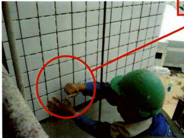
Foto 9: Ajuste do alinhamento vertical utilizando régua de alumínio
