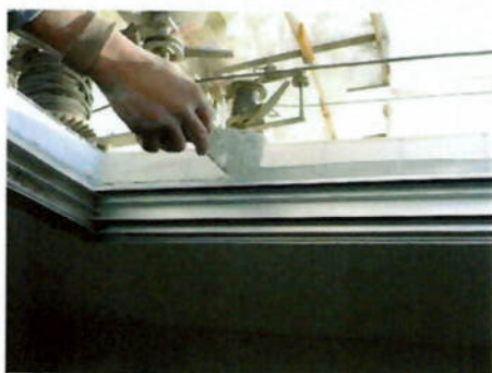
Foto 12: Preenchimento completo dos vãos
