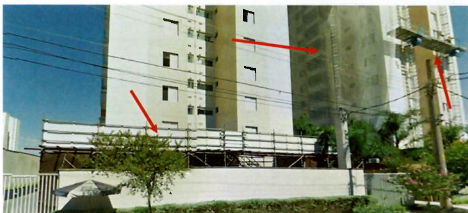
Foto 20: Vista da recuperação do revestimento da fachada
