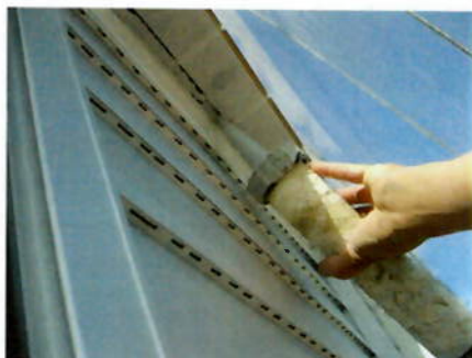
Foto 11: Aplicação de silicone. Retirar excesso de sujeira dos vãos
