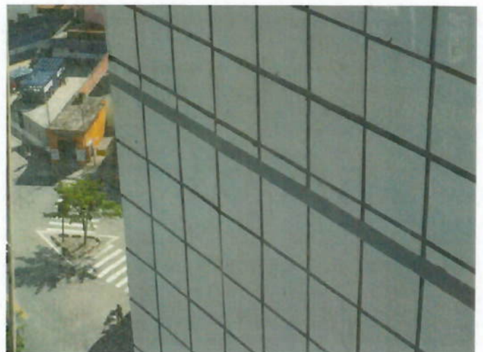
Foto 21: Aspecto final - vãos 100% preenchidos
