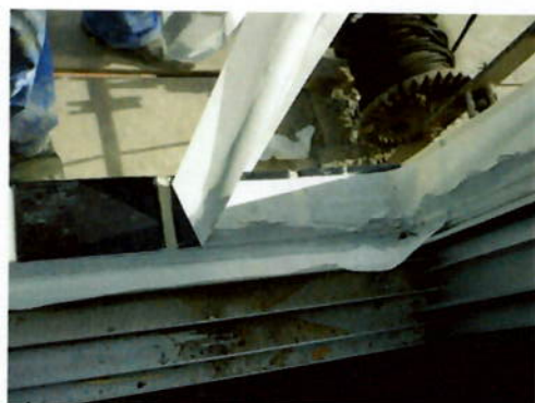
Foto 13: Retirada da fita logo em seguida. Mais difícil se o silicone estiver seco
