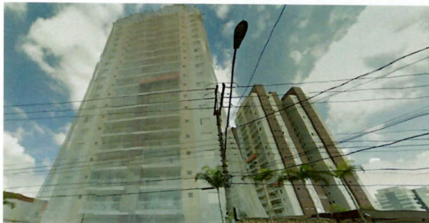
Foto 13: Vista da recuperação do revestimento da fachada
