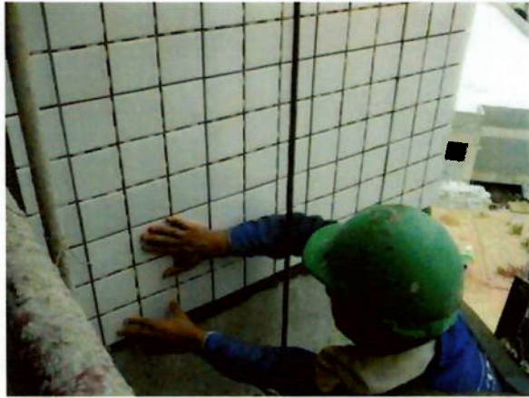
Foto 8: Ajuste do alinhamento vertical utilizando régua de alumínio
