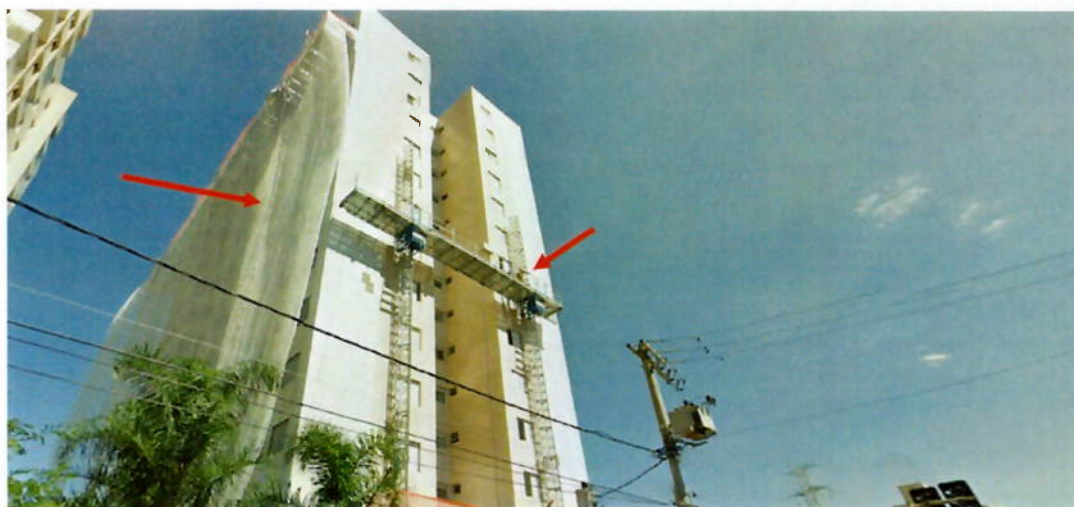
Foto 19: Vista da recuperação do revestimento da fachada
