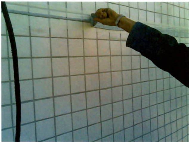
Foto 18: Preenchimento completo dos vãos - acabamento com espátula
