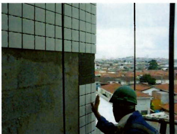
Foto 4: Atenção com as viradas para garantir alinhamento horizontal
