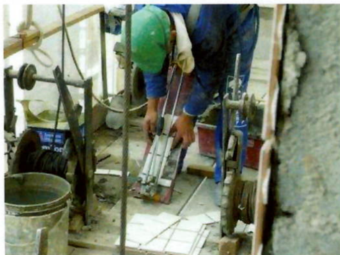
Foto 10: Riscar e cortar com auxílio de alicate
