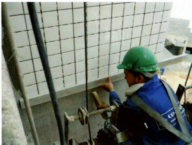
Foto 9: Ajuste do alinhamento vertical utilizando régua de alumínio
