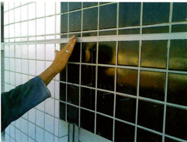
Foto 20: Arremate - usar o próprio dedo e água com detergente
