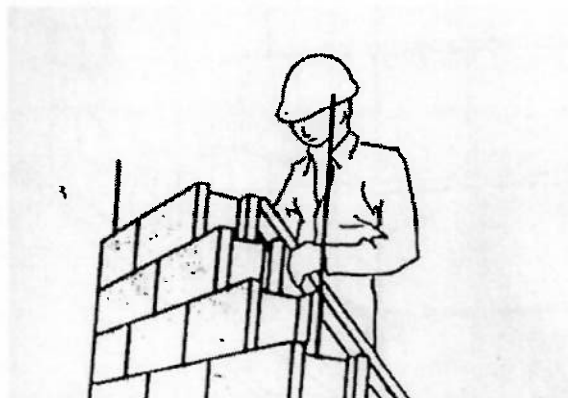
Figura 10: Verificação do alinhamento em diagonal
