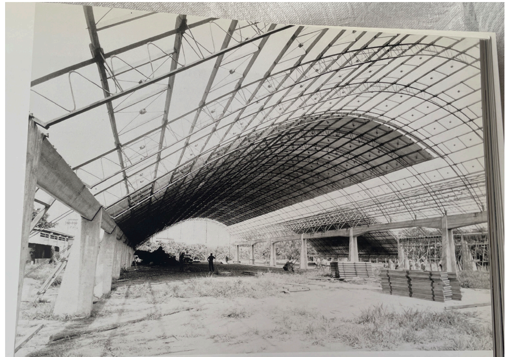
Figuras 49 e 50: Galpão e posto de Gasolina para caminhões da Tecelagem Paraíba, São José dos Campos, 1953. Rino Levi. Estrutura composta pela solda de vergalhões desenhando uma treliça planar. Fonte: IPHAN, 2021.
