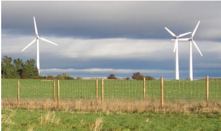
Figura 7: Geradores eólicos da comunidade. Fonte : (FEITEN et al, 2023).
