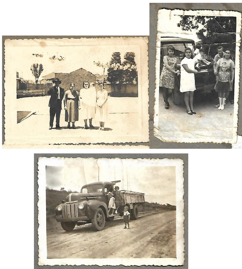
Figura 1 - Compilado de fotos tiradas na Rua Rocha Fraga, no Cangaíba.
