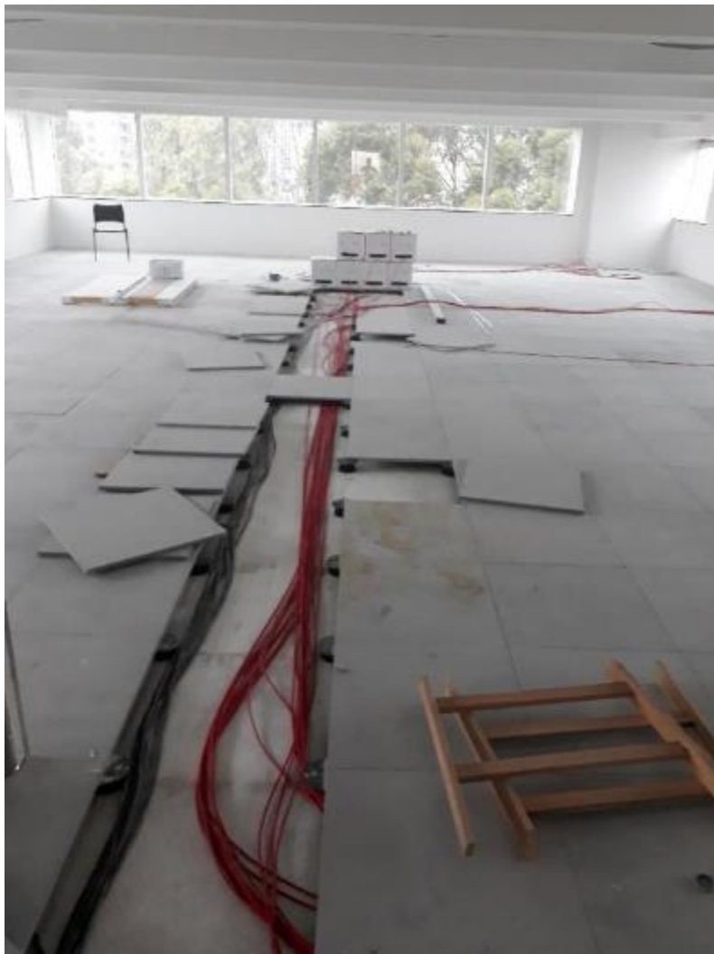
Figura 36 - Instalação de condutor elétrico no piso.
