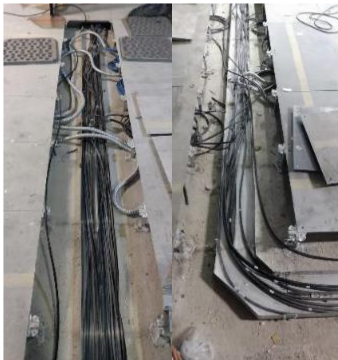
Figura 56 - Instalação de condutor elétrico no piso.
