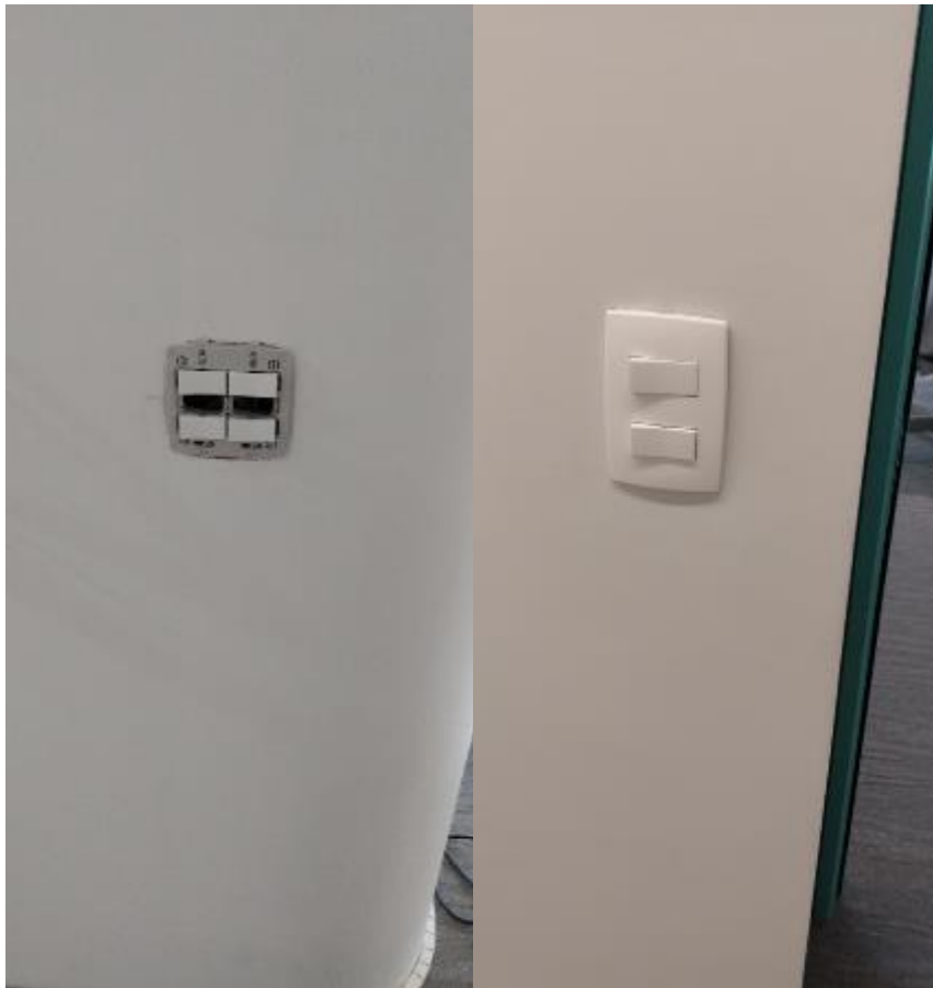
Figura 64 - Instalação de Interruptores.
