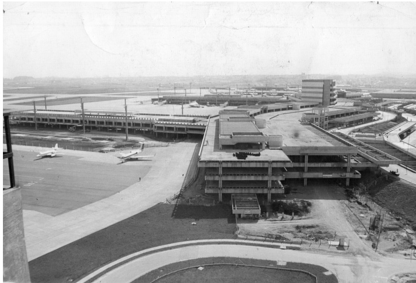
Figura 3 – Foto do Aeroporto Internacional de São Paulo - 1985 (GUARULHOS, 1987)
