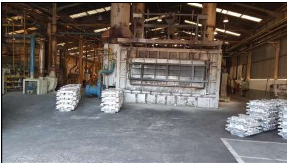
FIGURA 2 – Vista da porta do forno fechada e dos lingotes de alumínio de abastecimento do forno.
