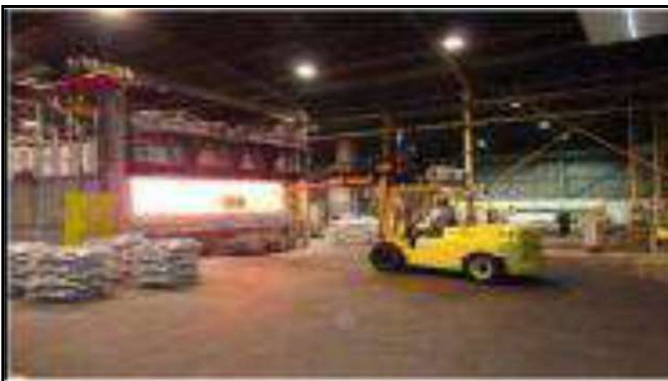
FIGURA 3 – Vista da porta do forno aberta durante o abastecimento dos lingotes de alumínio no forno.
