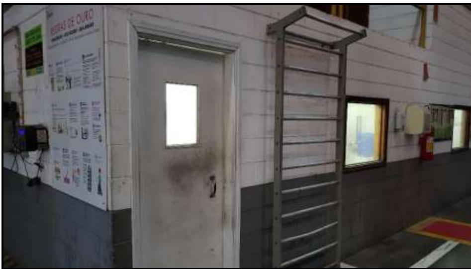
FIGURA 17 – Vista externa da entrada das salas de descanso e controle de qualidade.
