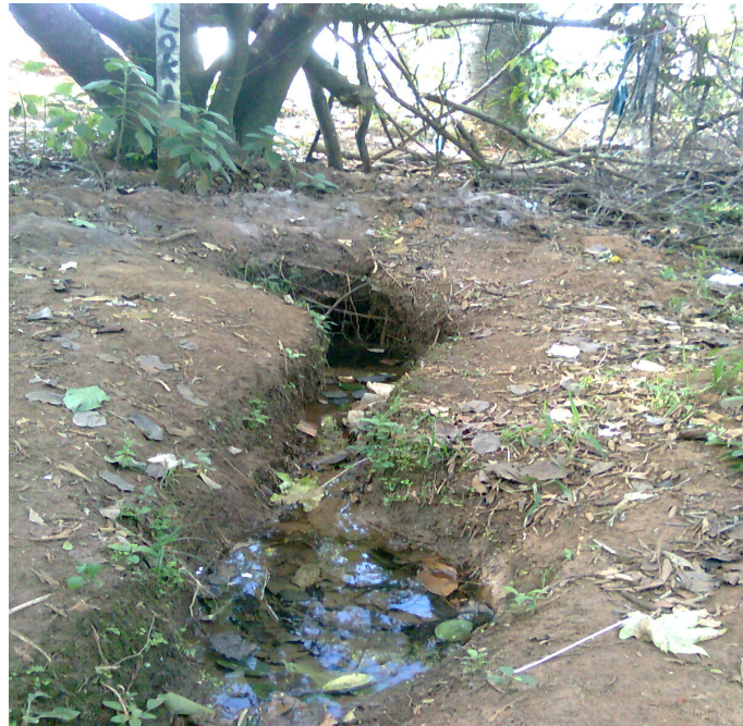
Figura 15. Segundo ponto de brotamento da nascente principal (detalhe para o solo totalmente exposto).
