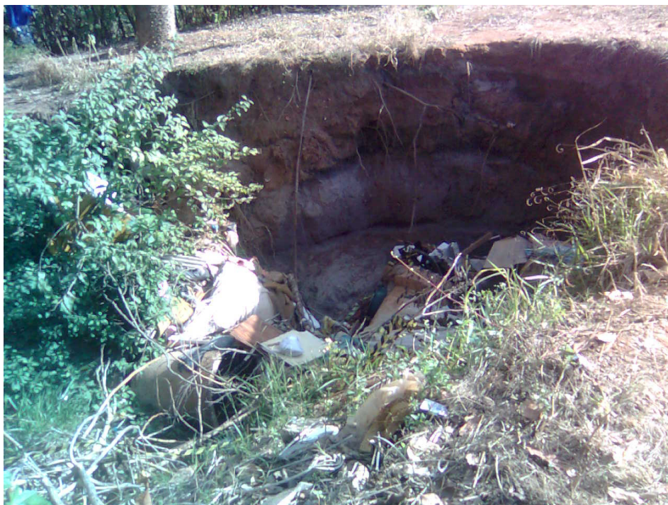
Figura 36. Nascente principal do córrego do Mineirinho com as tubulações de drenagem rompidas.
