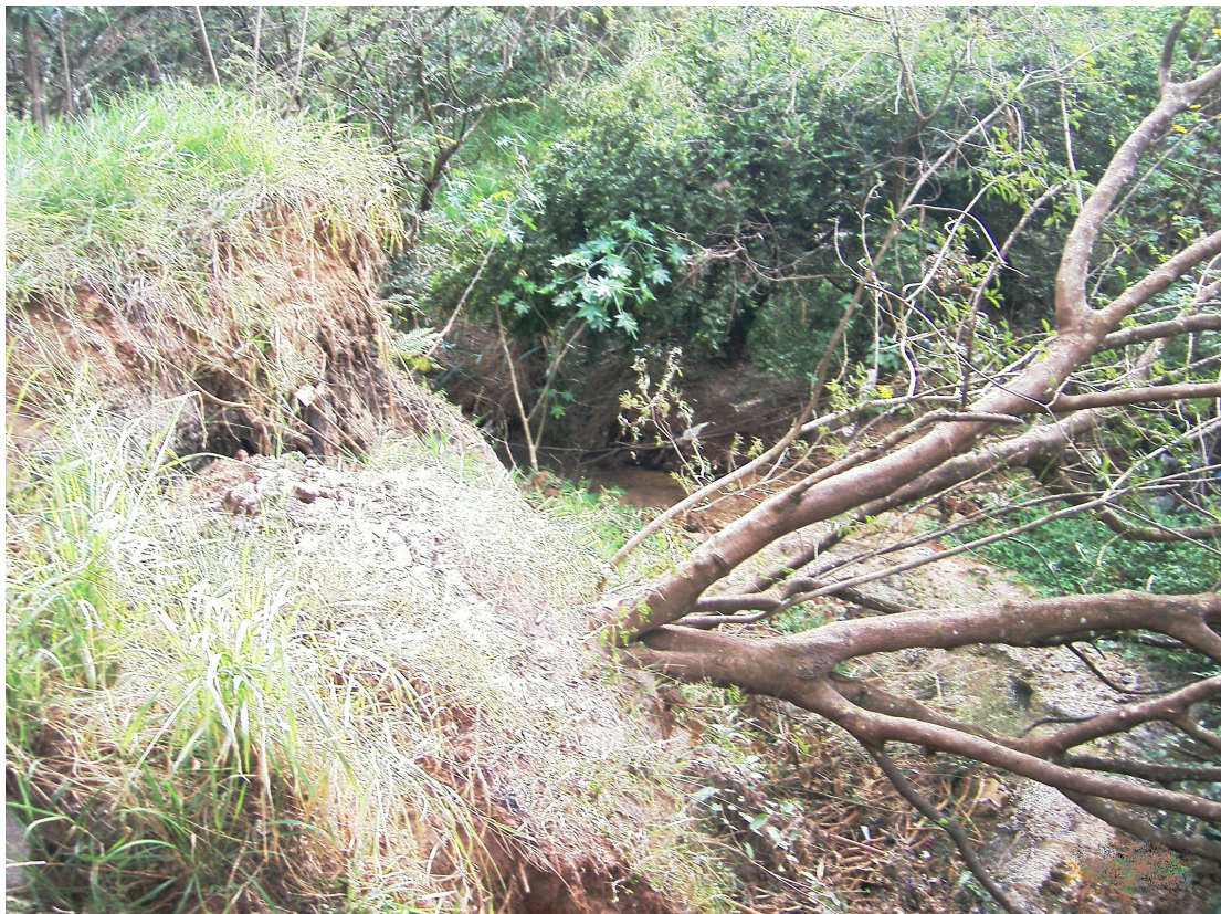
Figura 24. Voçoroca presente na APP da nascente do córrego Santa Fé.
