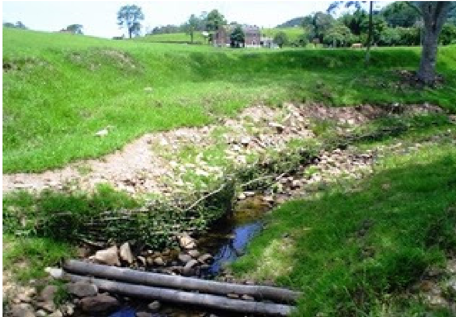
Figura 31. Margem do rio com presença da trança viva 1 mês após a aplicação.
