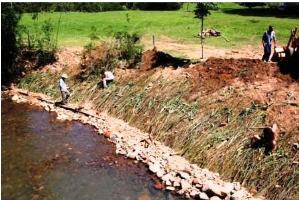
Figura 32. Esteira viva aplicada em beira de rio.
