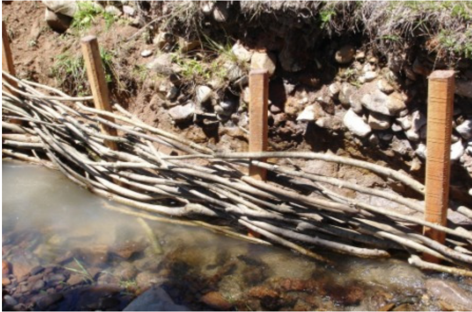
Figura 29. Construção de trança viva à margem de rio.
