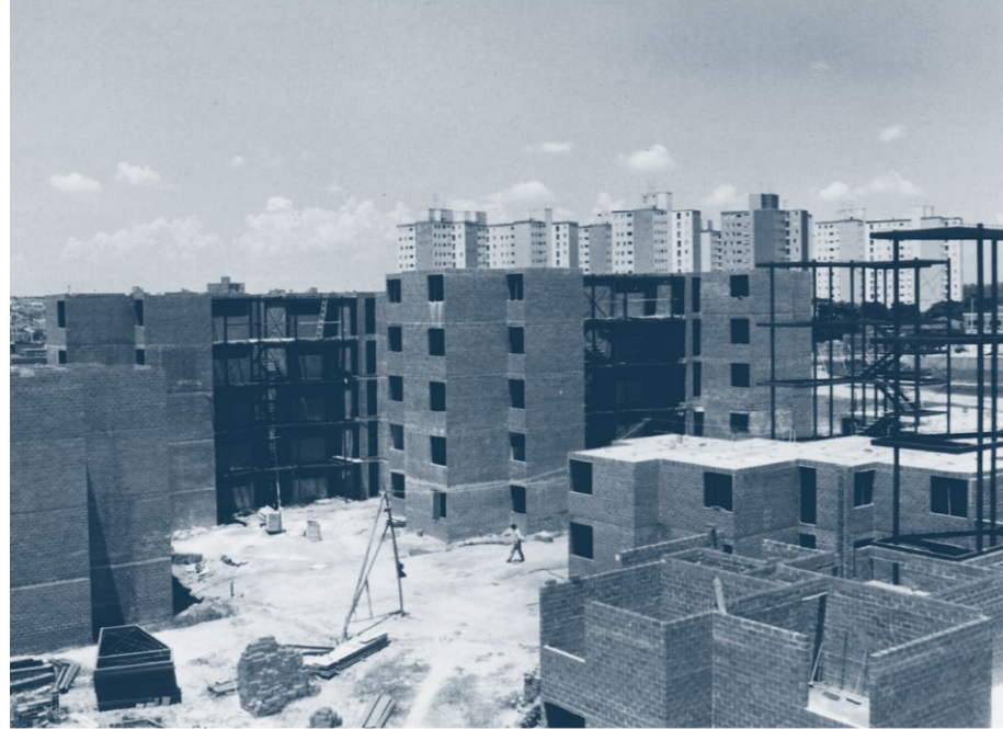
Imagem 30 | Obras em andamento | USINA CTAH
