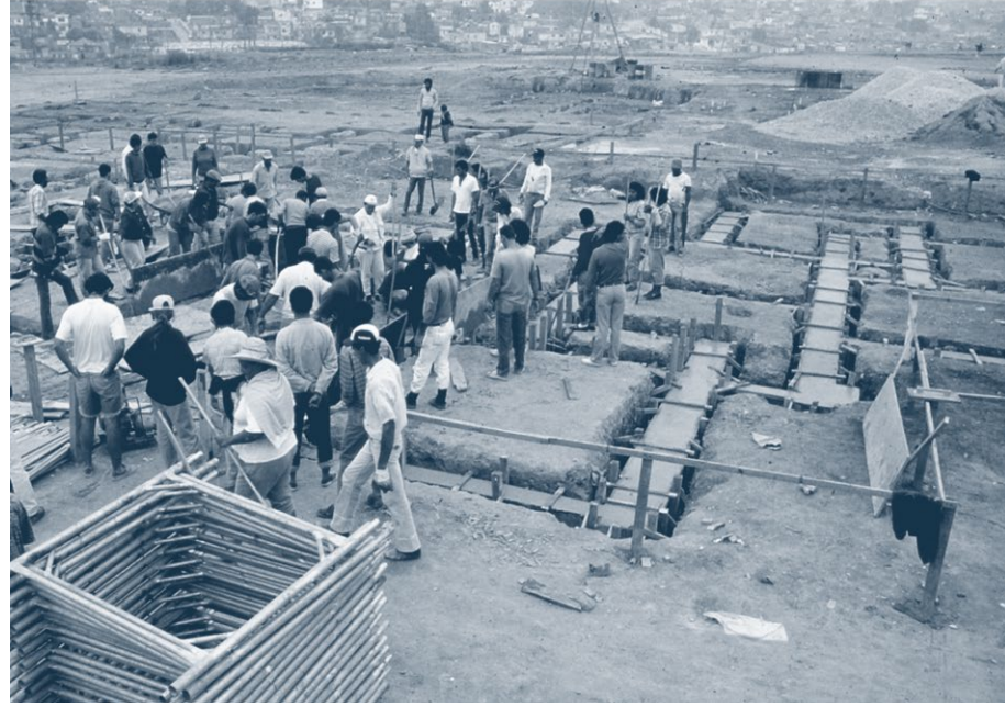
Imagem 31 | Mutirantes trabalhando na obra | USINA CTAH, 1993
