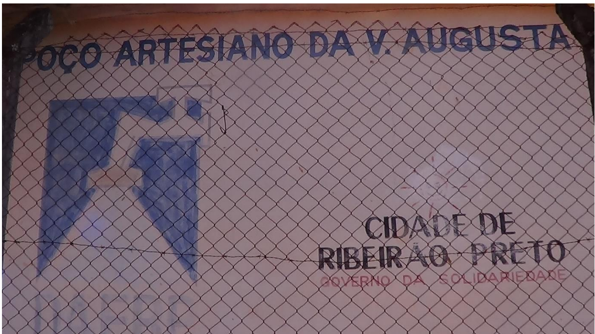
Figura 5 – Estação elevatória Vila Augusta
