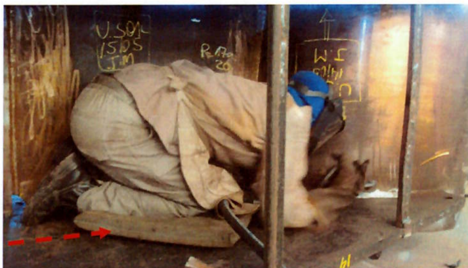
Figura 16 – Soldagem externa de equipamento, soldador em posição ajoelhada em uma almofada de raspa e agachado para melhor posição do local da aplicação da solda. Fonte: Lima, 2010
