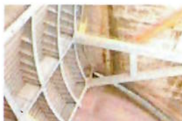
Figura 5 – Comporta do vertedouro Fonte: Cidade de Tucuruí
