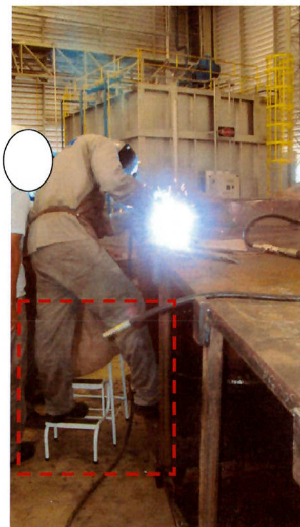
Figura 17 – Soldagem externa da comporta, soldador em exposição a diferença de nível, local demarcado Fonte: Lima, 2010
