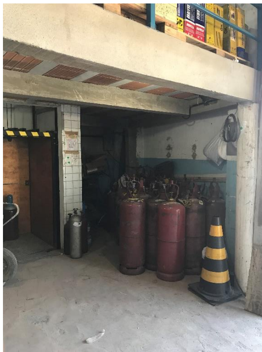
Figura 17 – Armazenamento de cilindros de acetileno atualmente.
