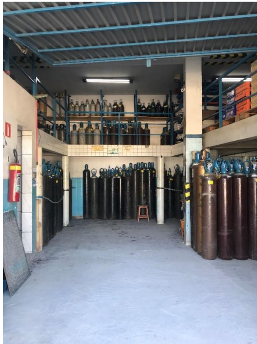
Figura 9 – Armazenamento de cilindros cheios e vazios.
