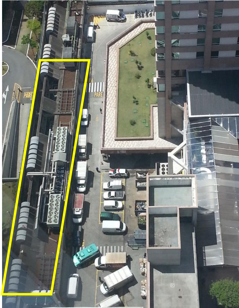
Figura 4-6: Foto aérea da localização do District Cooling, destacada em amarelo, projetada para ser instalada na área de docas do Complexo, originalmente local da CAG Hotel/ Convenções/ Golden Hall Fonte: Fotografia tirada pelo autor
