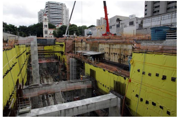
Figura 3: Expansão da Linha 5 – Lilás, na Futura Estação Moema, zona Sul de São Paulo. Fonte: METRÔ (Janeiro, 2015).
