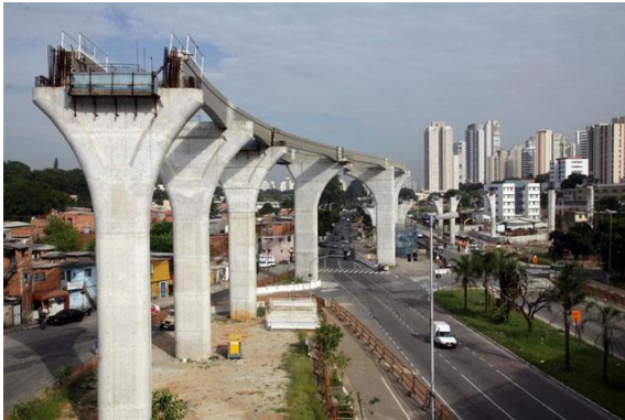
Figura 4: Construção da Linha 17 – Ouro. Fonte: METRÔ (Janeiro, 2015).
