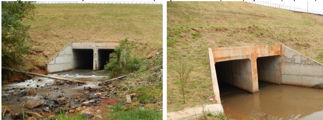
Figura 73 – Galeria após as obras de recuperação: montante (direita) e jusante (esquerda)
