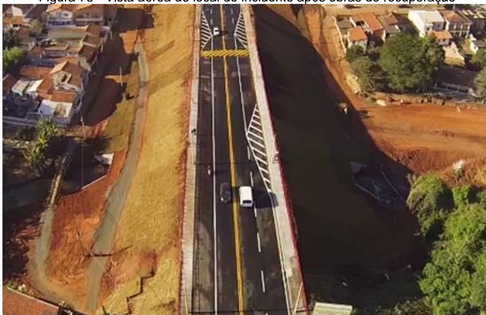
Figura 78 - Vista aérea do local do incidente após obras de recuperação
