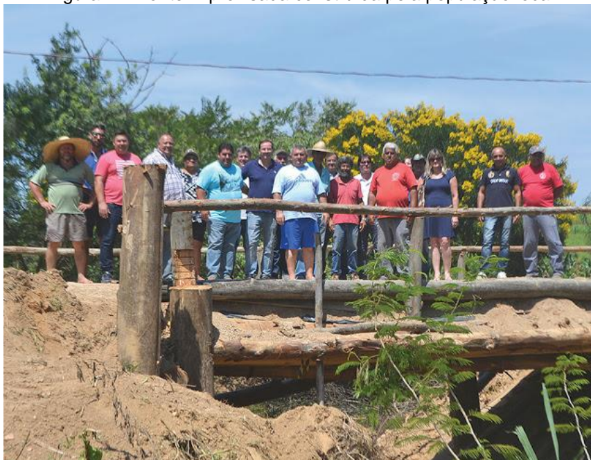
Figura 2 – Ponte improvisada construída pela população local
