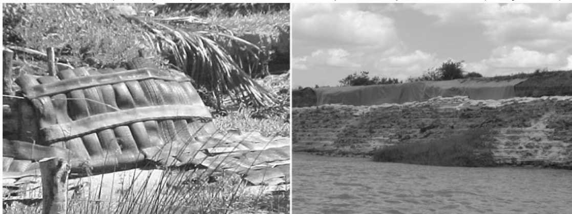
Figura 21 - Contenção dos taludes marginais utilizando borracha de pneus velhos (esquerda) e sacos de areia (direita), nas proximidades do Município de Brejo Grande/SE (março/2004)
