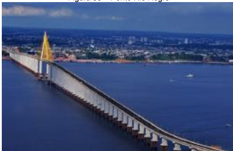
Figura 35 – Ponte Rio Negro
