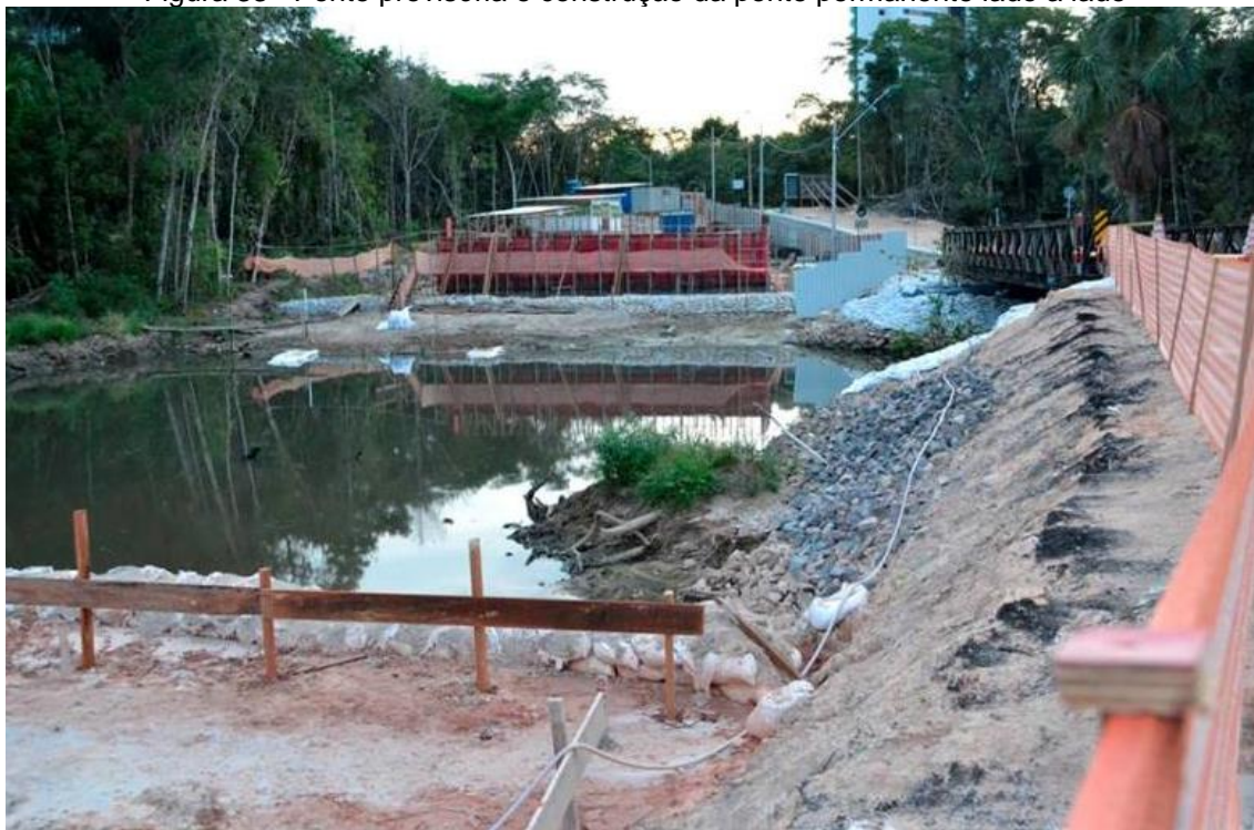
Figura 33 –Ponte provisória e construção da ponte permanente lado a lado
