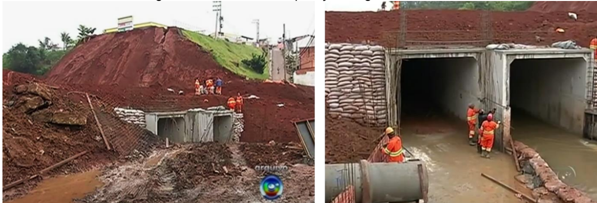
Figura 72 - Obras de recuperação da galeria e da via
