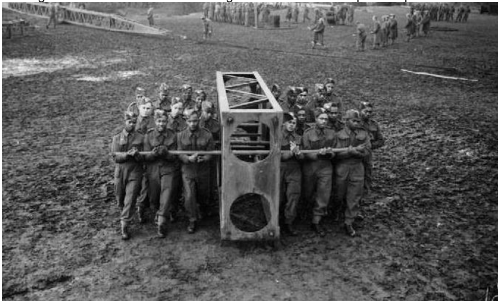
Figura 13 – Painel da Ponte em Viga Caixão sendo transportado por soldados
