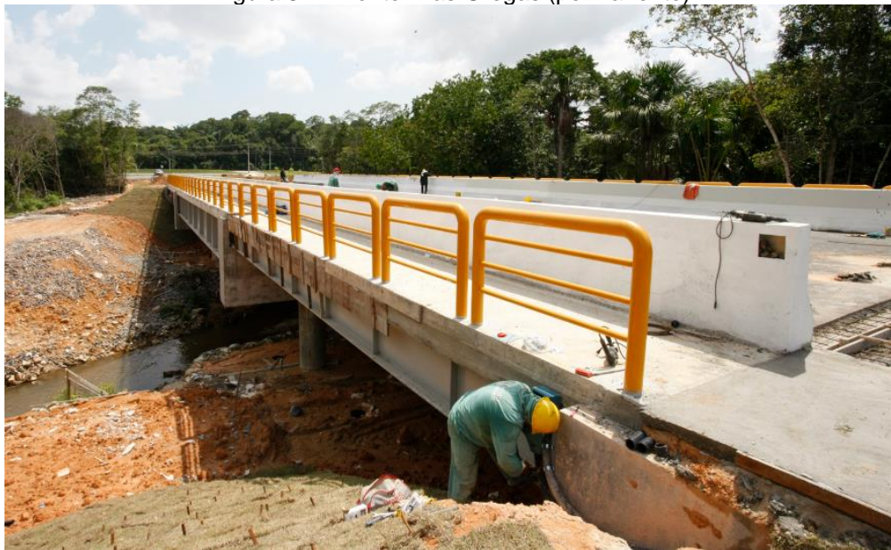
Figura 34 – Ponte ilhas Gregas (permanente)
