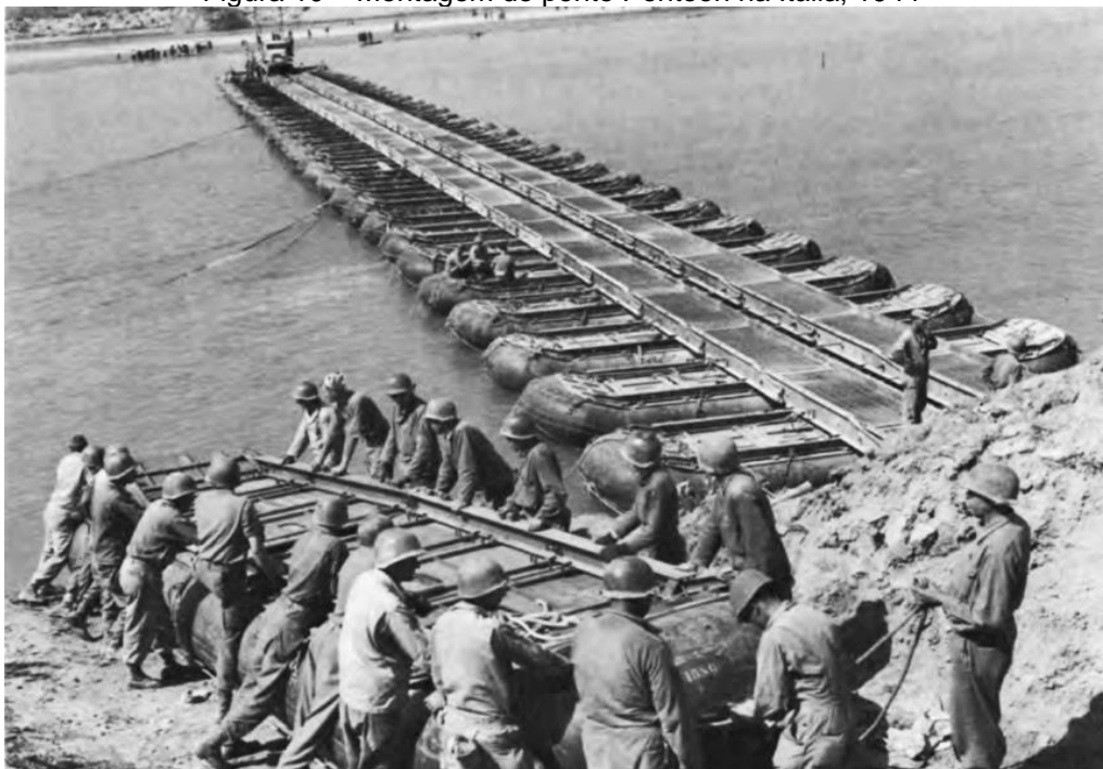
Figura 10 – Montagem de ponte Pontoon na Itália, 1944
