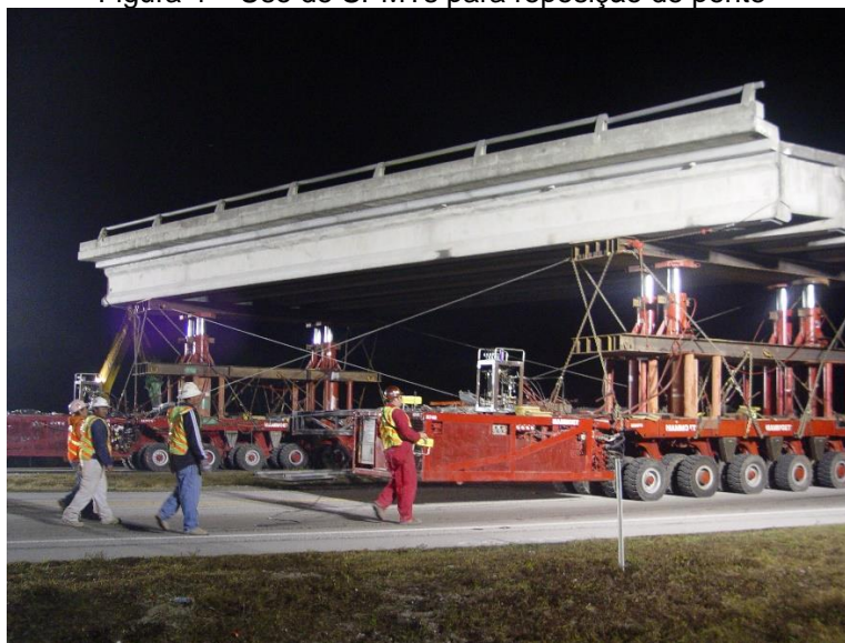
Figura 4 – Uso de SPMTs para reposição de ponte
