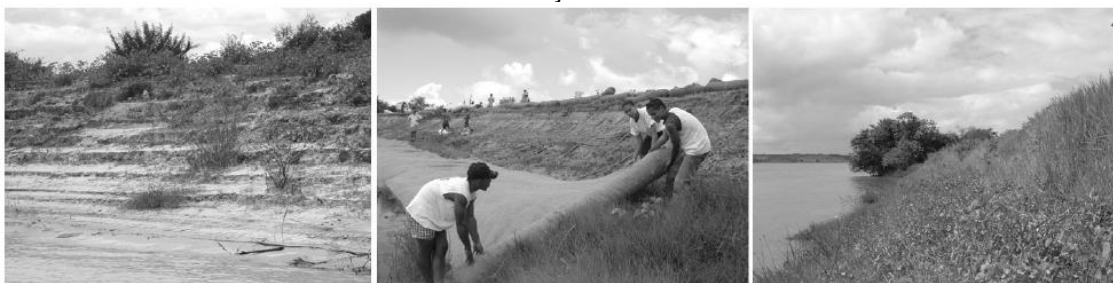
Figura 24 - Implantação da bioengenharia de solos no talude marginal do rio São Francisco, no Perímetro Irrigado Cotinguiba-Pindoba: Talude antes da instalação (esquerda); Instalação do geotêxtil (centro); Talude 60 dias após a implantação (direita) (Período de julho/2004 a março/2005)
