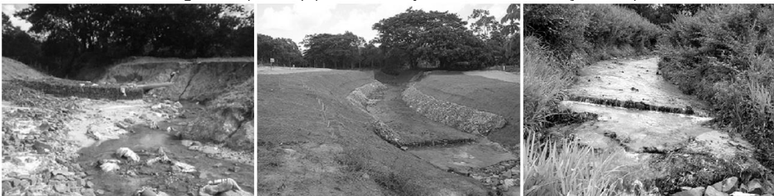
Figura 25 - Fases da implantação da bioengenharia nas margens do Rio Paramopama: Margem erodida (esquerda); Implantação do geotêxtil e colchão Reno (centro); Margem revegetada (direita) (Período de janeiro/2007 a março/2008)
