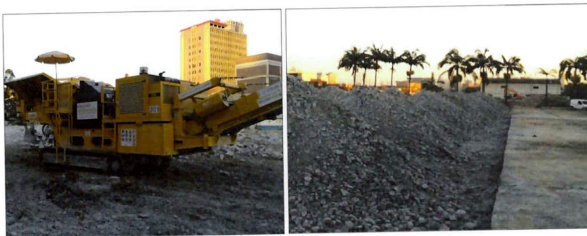
Figura 1- Britador de mandíbulas móvel no local da demolição e o concreto após britagem
