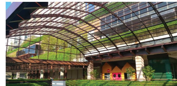
Cobertura retrátil do Shopping Cidade Jardim, Paulo Dias. Foto de autor desconhecido In: https://revistashoppingcenters.com.br/noticias/shopping-cidade-jardim-tem-maior-cobertura-retratil-de-acrilico-do-pais/ acessado em 15/11/19
