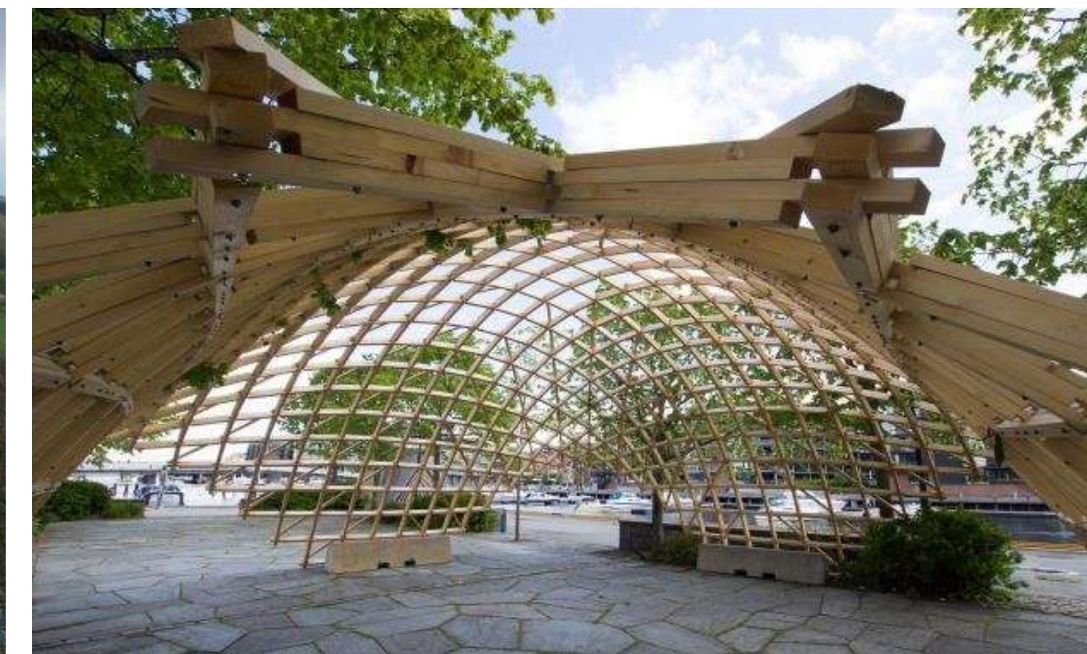
Fotografia do projeto Trondheim Pavilion, experimentação estrutural de simplificação de estruturas em gridshell. Artigo que baseou a estrutura do dado trabalho. Fonte: https://www.researchgate.net/figure/Fully-erected-pavilion-viewed-from-one-of-the-entrances_fig14_332621609 Acesso em 03/12/2022.
