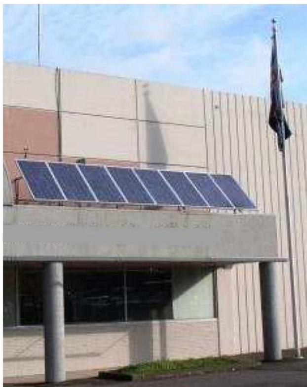
Figura 43 - Sistema fotovoltaico de 1320 Wp instalado em Salem, Oregon, sombreado pelo mastro de bandeira [31]
