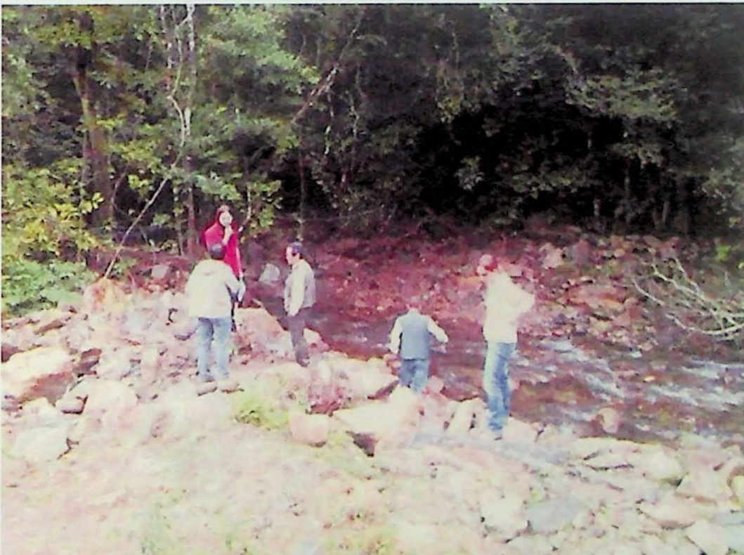
Figura 18 – Local de rompimento da margem da drenagem, o material da margem foi reposto pela prefeitura junto com a remoção do depósito que se formou na Rua Belo Horizonte.
