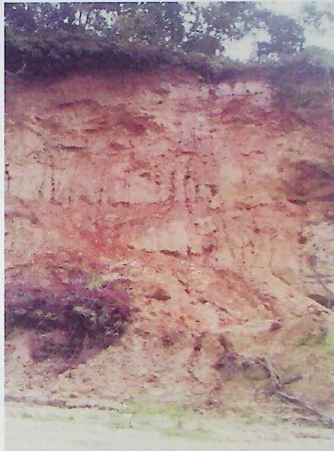
Figura 20 – Corte da Rua Belo Horizonte todo em solo com aproximadamente 10 metros de altura.
