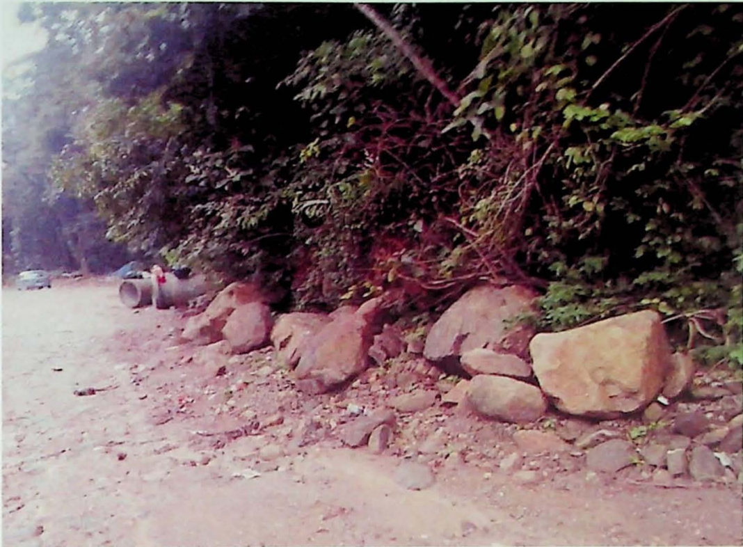
Figura 17 – Blocos de rocha gnaissica e granítica na beira da Rua Belo Horizonte nas proximidades do Ponto 2.
