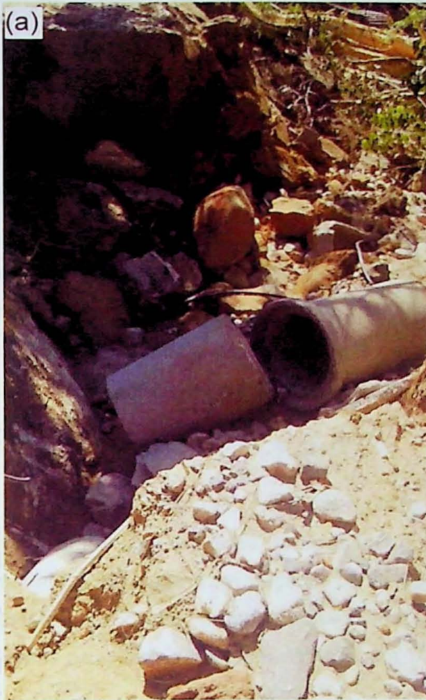
Figura 27 – (a): Rede de esgoto danificada. (b): Bloqueio da Rua Belo Horizonte invadida pela corrida de detritos, derrubando as árvores do local.
