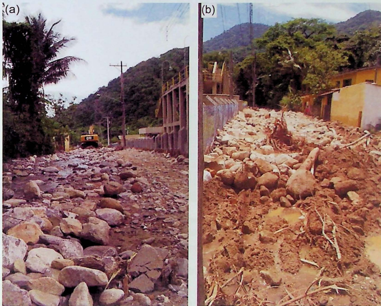
Figura 25 – (a): Depósito de blocos e matacões ao longo da Rua Belo Horizonte. (b): Porção Frontal do depósito de blocos da corrida de detritos, é possível identificar de forma grosseira a granulometria inversa dos materiais (poucos dias após o evento).
