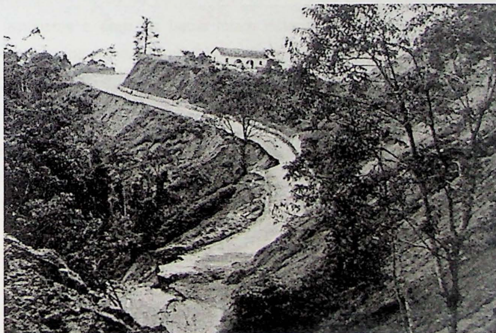
Figura 13 – Rodovia dos Tamoios destruída (Acervo do Arquivo Municipal de Caraguatatuba).
