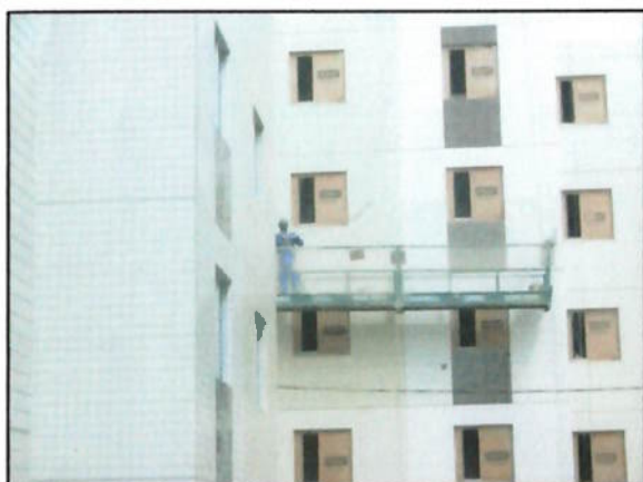
Figura 19 - Revestimento cerâmico externo
