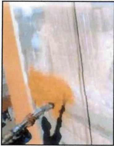
Figura 29 - Execução de monocapa
