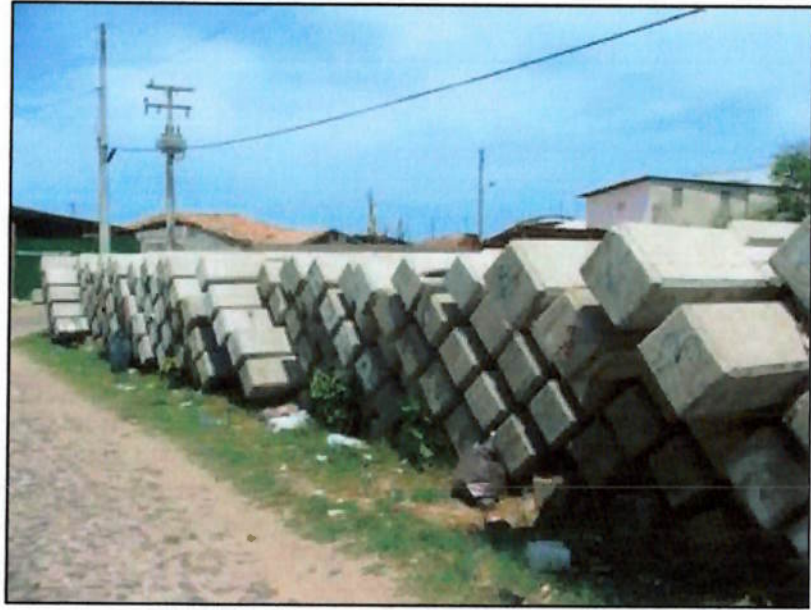
Figura 21 - Estacas de concreto pré-moldado
