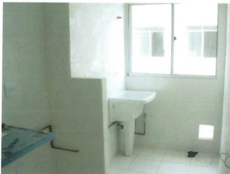
Figura 26 - Revestimento cerâmico interno
