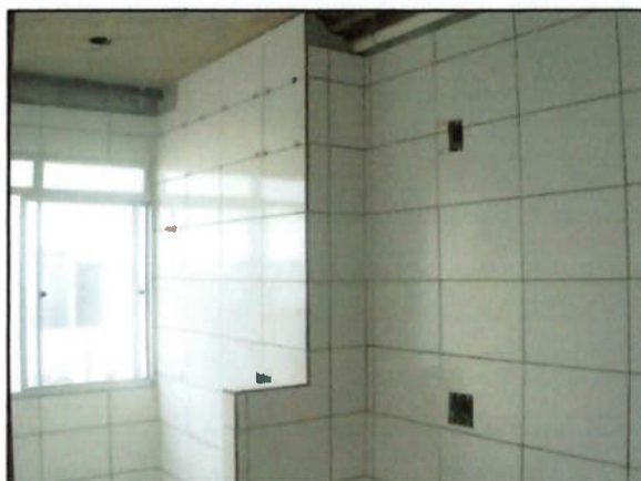
Figura 18 - Revestimento cerâmico interno
