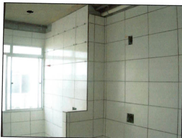
Figura 25 - Revestimento cerâmico interno
