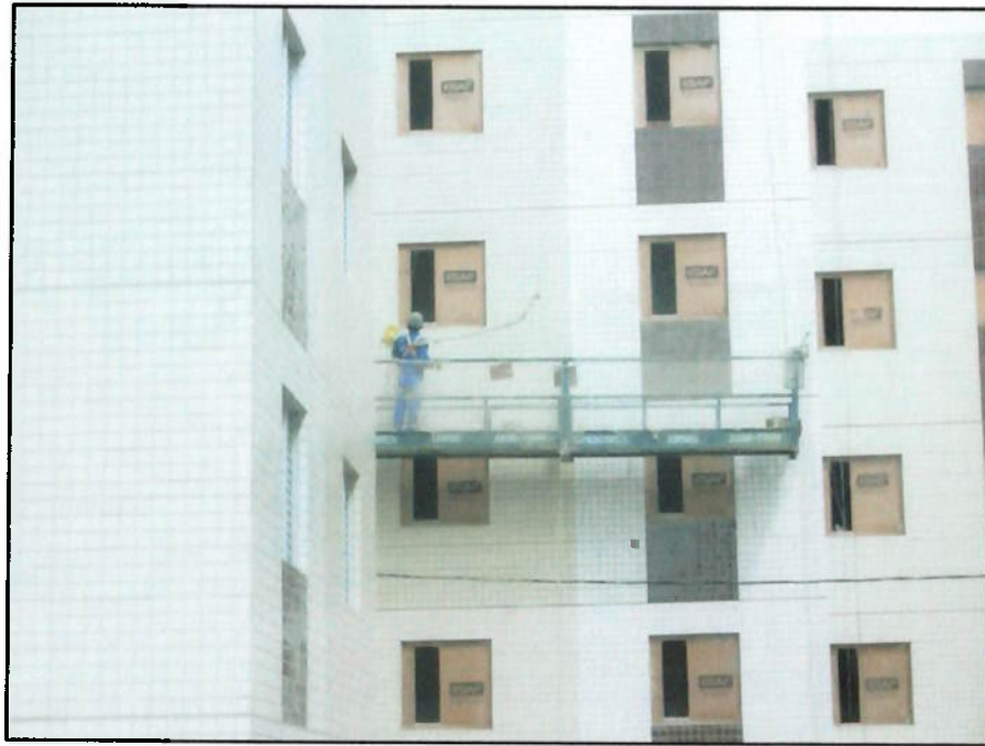
Figura 27 - Execução de cerâmica na fachada
