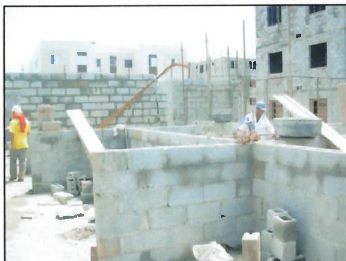
Figura 22 - Execução de alvenaria estrutural
