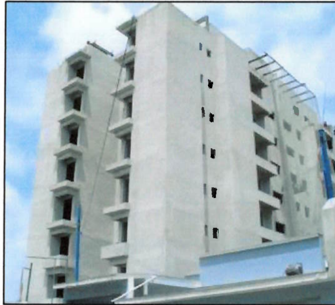
Figura 28 - Fachada com argamassa
