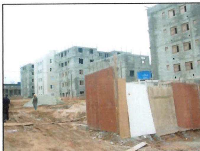
Figura 23 - Execução de alvenaria estrutural
