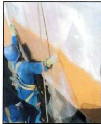
Figura 30 - Execução de monocapa
