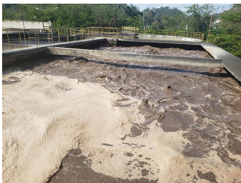
Figura 4.5: Tanque de aeração com aeradores submersos
