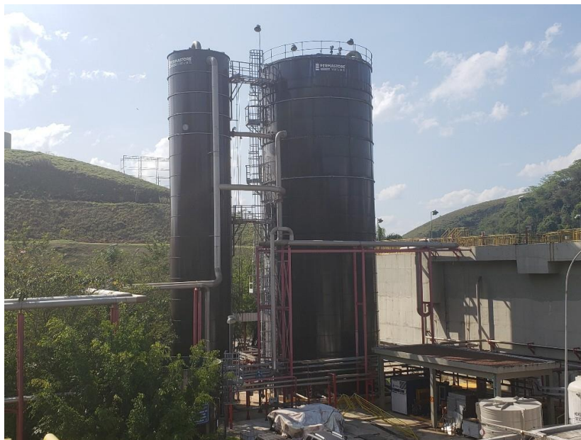
Figura 4.4: Reator anaeróbico tipo Circulação Interna
