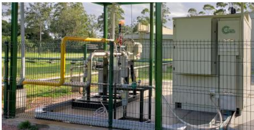
Figura 4.11: Sistema de regulagem de pressão do biogás.
