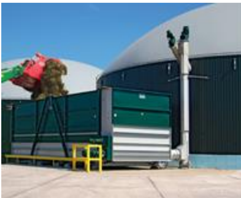
Figura 5.3: sistema de alimentação de substrato sólido.
