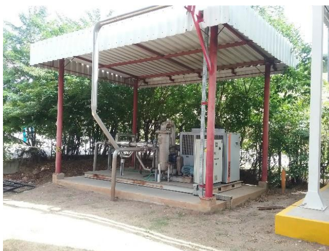
Figura 4.10: Planta para a secagem e medição do biogás
