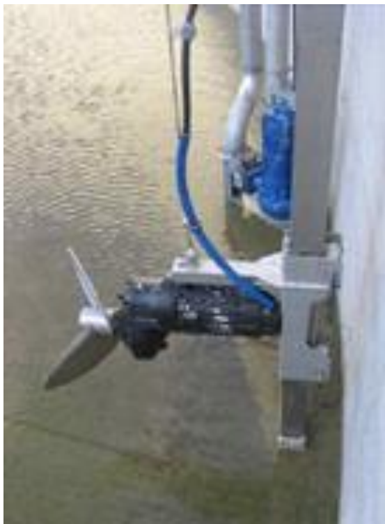
Figura 5.6: Sistema de agitação com motor submersível.
