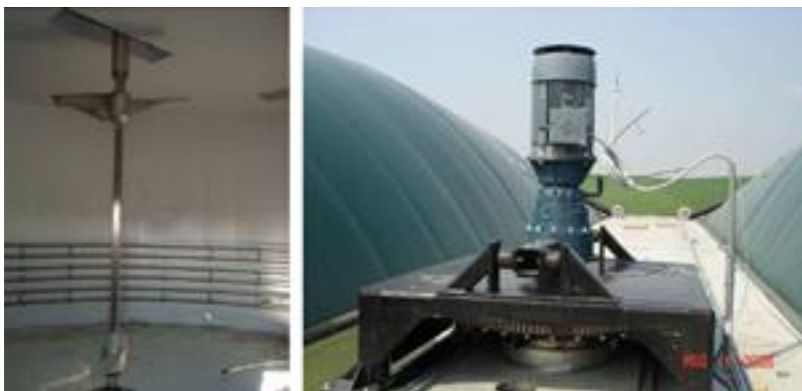
Figura 5.7: sistema de agitação com motor externo e eixo vertical.
