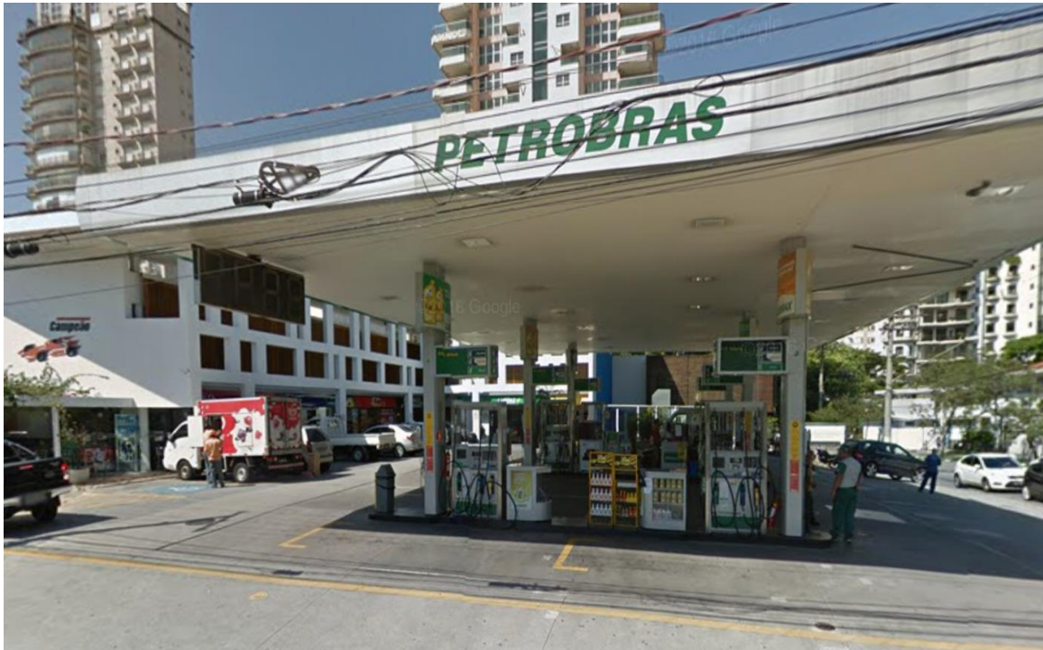
Figura 5: Centro comercial com posto de gasolina - Av. República do Líbano (Google maps)
