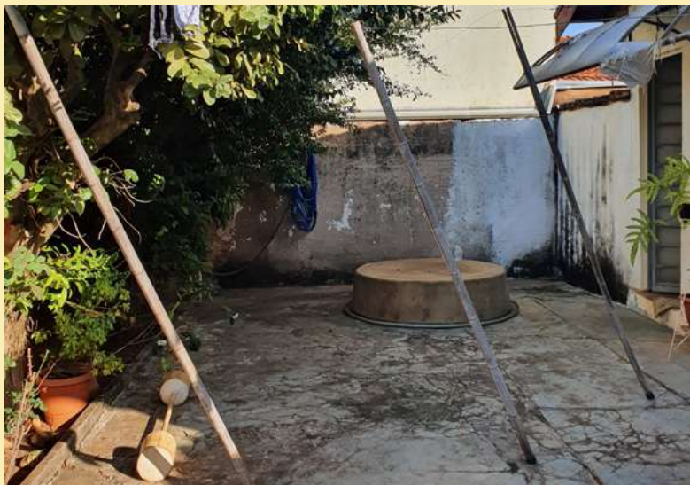
(↑) Estrutura de varal em bambu e arame; peso em concreto e barra.
