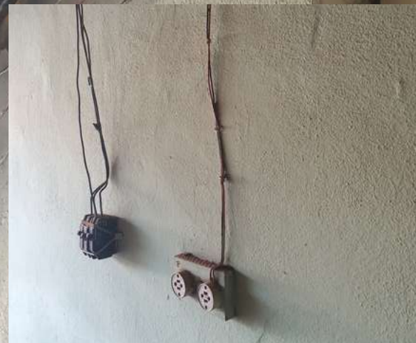
(↑)(→) Vestígios do sistema elétrico trifásico nas paredes.
