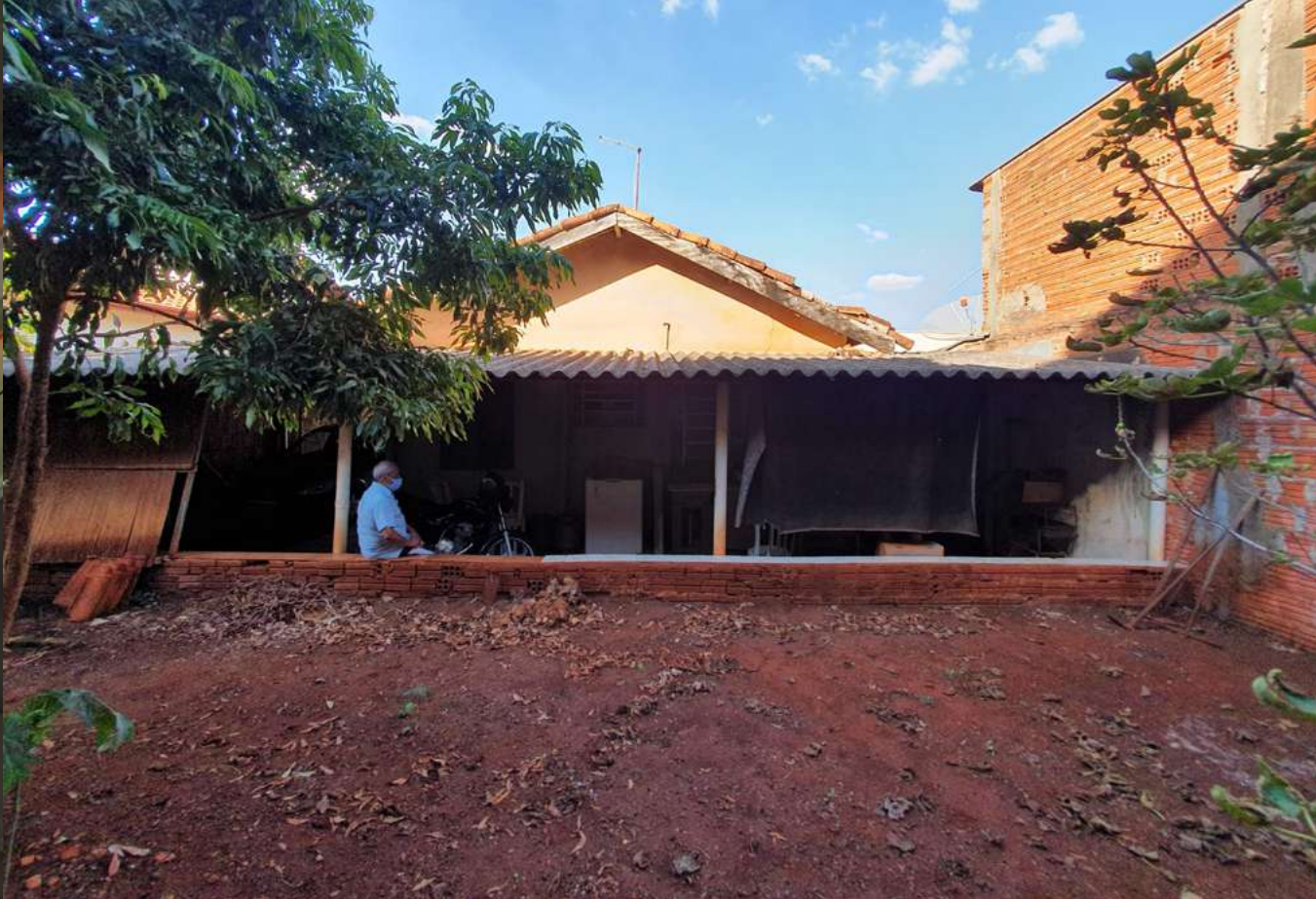
(↑) Vista da casa a partir do canteiro.
