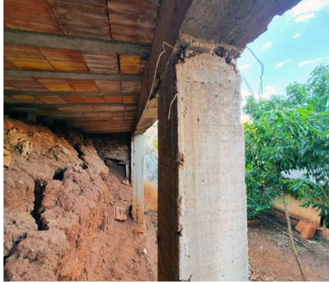
(↑) Pilares de concreto e laje que estruturam o terreno da casa vizinha.
