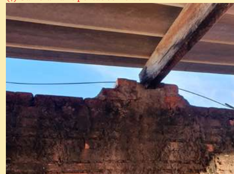
(↑) Extensão para apoio de viga ao muro.
