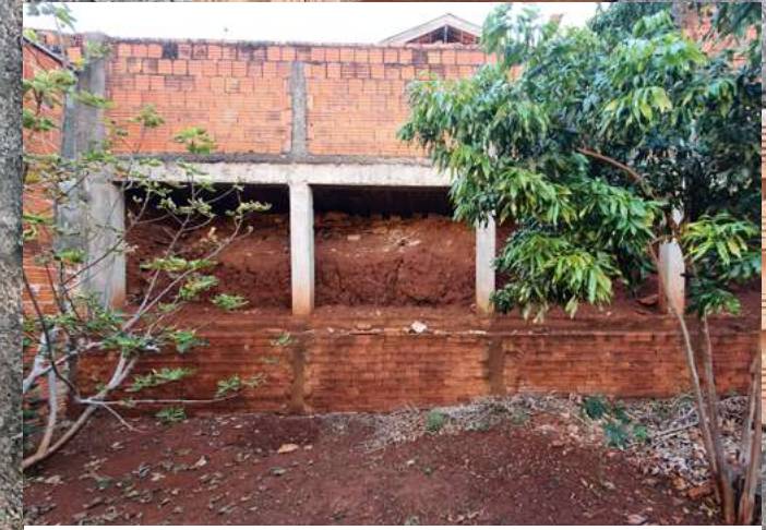
(↑) Taludê cavado e transformado em escoras.
