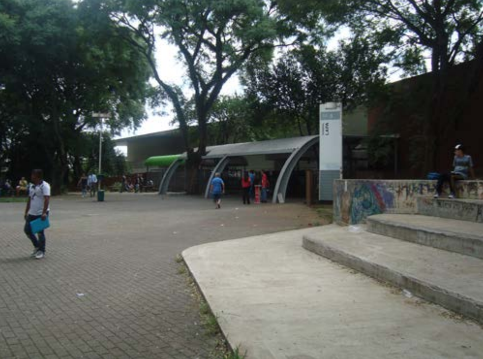
• FOTO: Acesso para o Terminal da Lapa | Fonte: Acervo próprio da autora.
