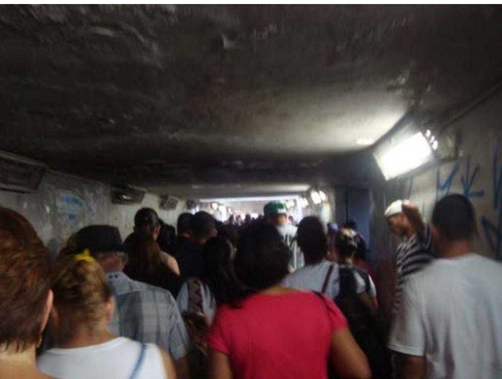
• FOTO: Espaço interno do túnel em um momento de recém chegada de um trem na estação | Fonte: Acervo próprio da autora.
