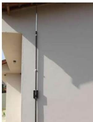
Figura 4 – Subsistema de descida
