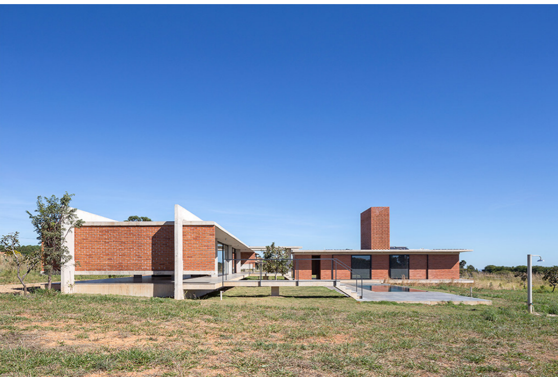
Figura 26: Casa Vila Rica. Foto: BLOCO Arquitetos. Disponível em: < www.bloco.arq.br/arquitetura/casa-vila-rica/ >. Acesso em: 3 out. 2021.
