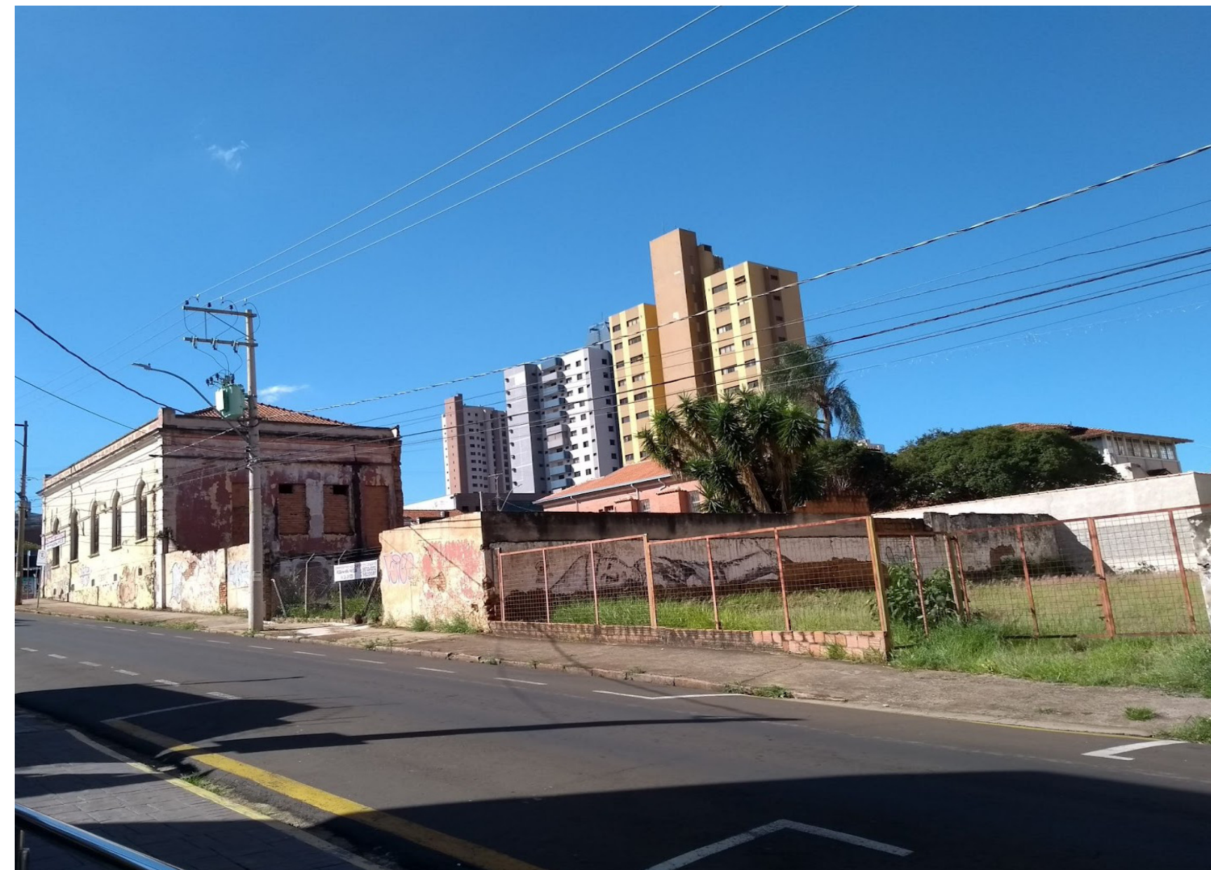
FACHADA RUA SÃO JOAQUIM Foto autora, 2022
