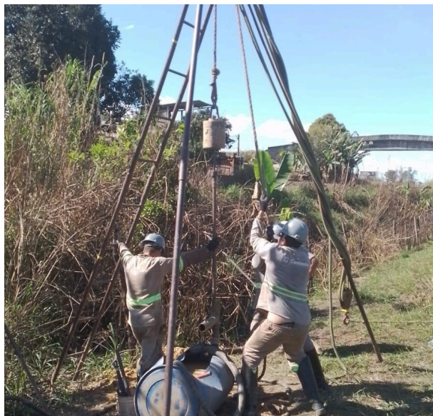
Figura 7- Martelo padronizado para cravação do amostrador, na Ilha 02.
