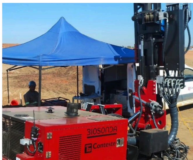
Figura 9- Ensaio CPTu em execução na Ilha-05.
