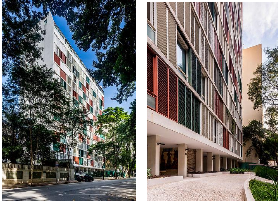
Figura 8 - Edifício Lausanne – painéis em alumínio na fachada
