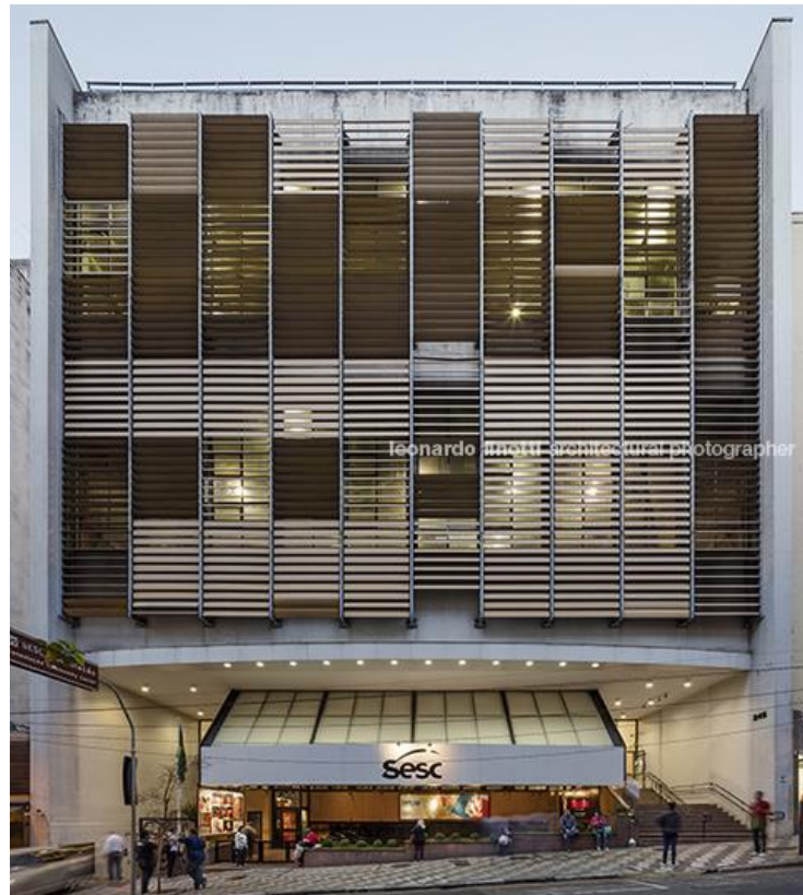
Figura 27 – Brises da fachada atual do Sesc Consolação
