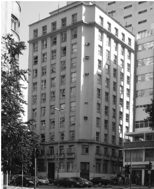
Figura 4 - Edifício Santa Margarida, Jacques Pilon – marcação vertical da fachada
