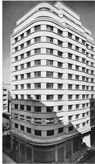
Figura 3 - Edifício São Manoel, Pilon & Matarazzo – frisos horizontais na fachada e marcação arredondada na esquina
