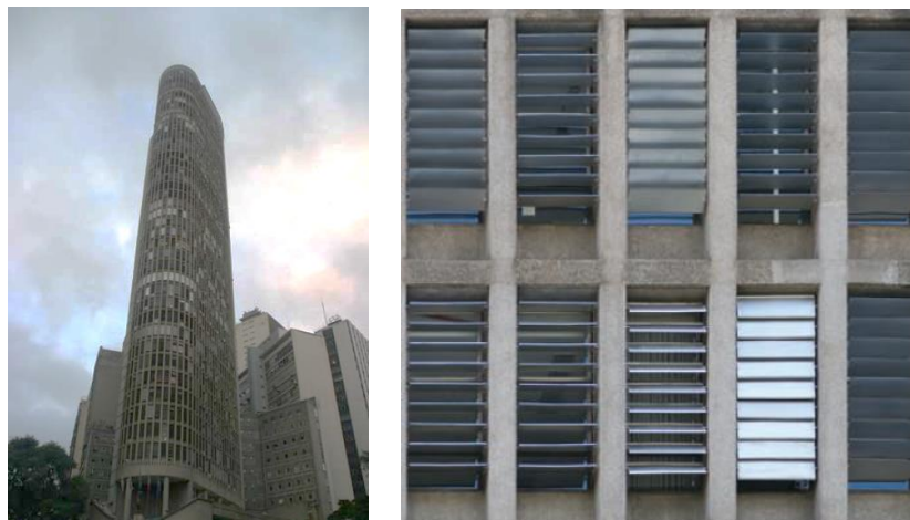
Figura 9 - Edifício Itália - fachada em grelha e brises
