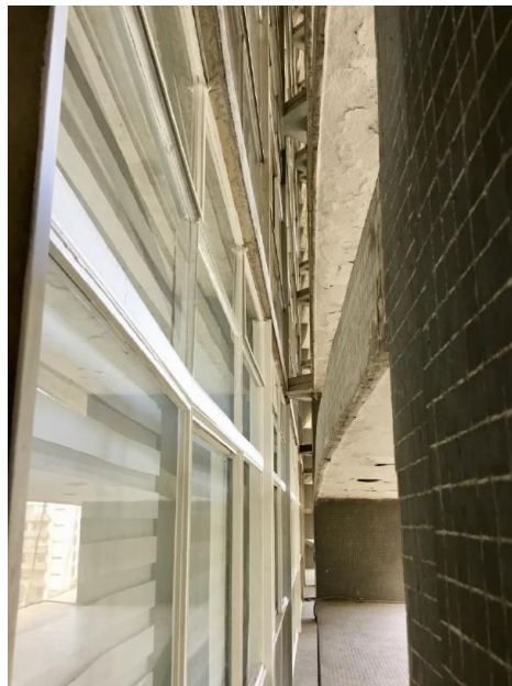
Figura 11 – Elementos metálicos de fixação dos brises do Copan
