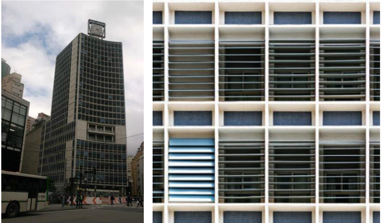
Figura 7 - Edifício O Estado de São Paulo - fachada em grelha e brises
