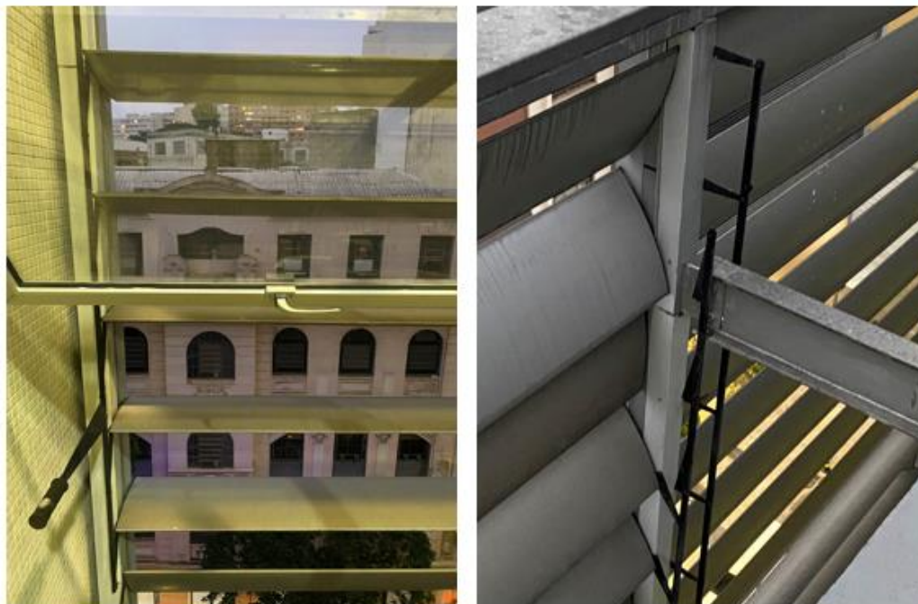
Figura 28 – Acionamento móvel dos brises
