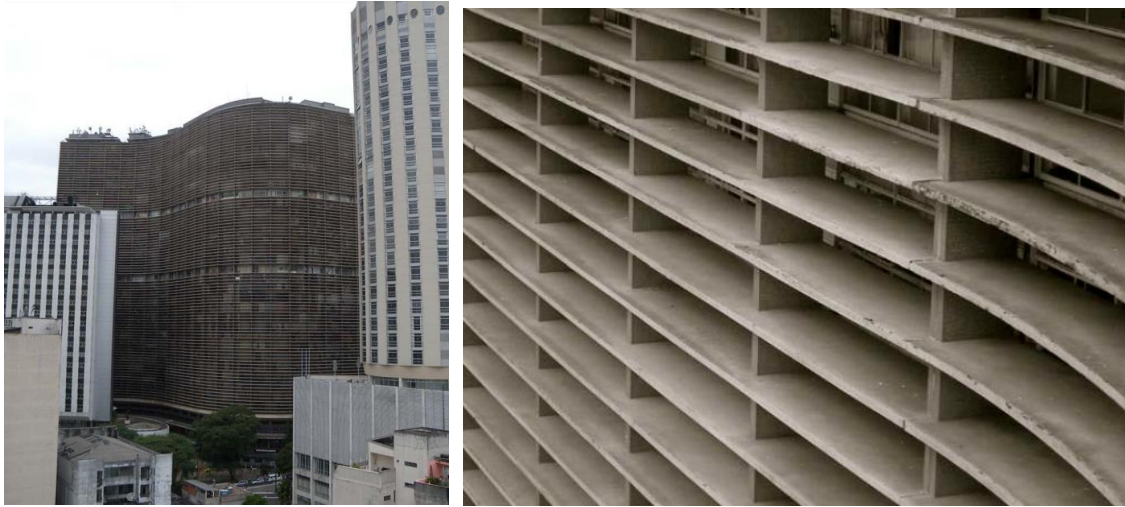
Figura 10 – Edifício Copan – brises em concreto armado
