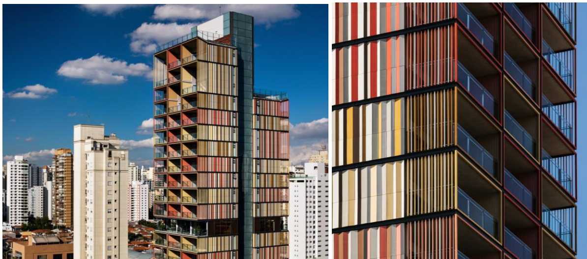
Figura 16 – Edifício Residencial Forma Itaim – Brises verticais no fechamento lateral das varandas
