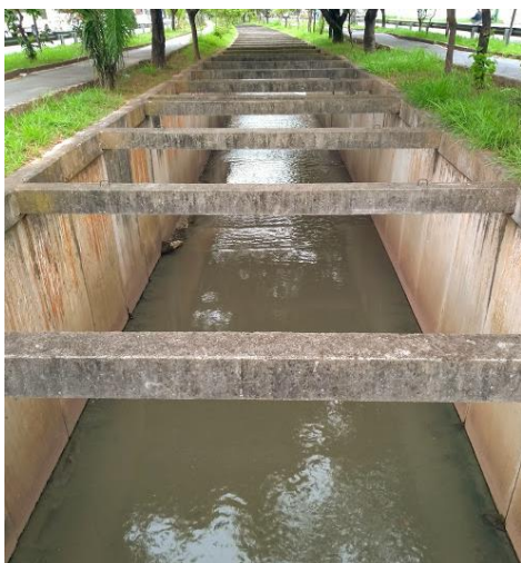
Fig. 12 – Médio curso do rio Bussocaba, Osasco/SP, aprofundado e completamente revestido. Foto: Ana Paula de Souza, 2018.
